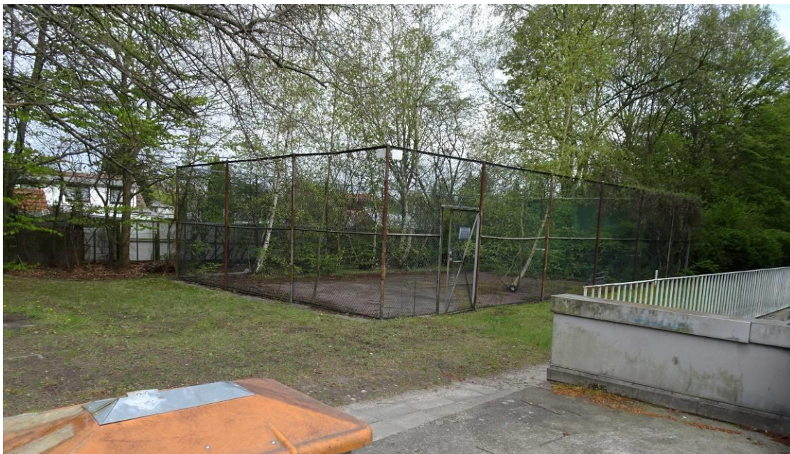
Abb. 6: Verdichtungsfläche im Bereich einer ungenutzten Sportanlage
