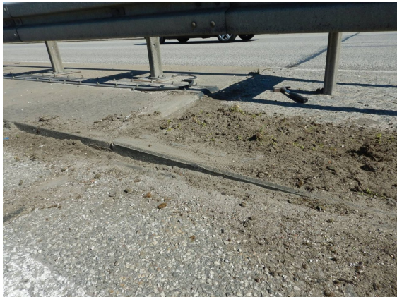
1839511_1_2018H_A10 RE SCHRAMMBORDABSSENKUNG
