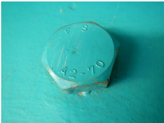
1839511_1_2018H_SCHRAUBEN ZUM VERSCHLUSS DER LÖCHER F KIPPAUSSTEIFUNG
