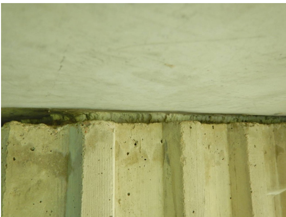
1839511_1_2018H_A10 LI SCHALUNGSRESTE KRAGARM - WL
