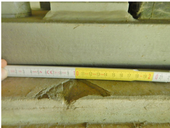
1839511_1_2018H_A10 QUERFESTES LAGER UNTERSTOPFUNG
