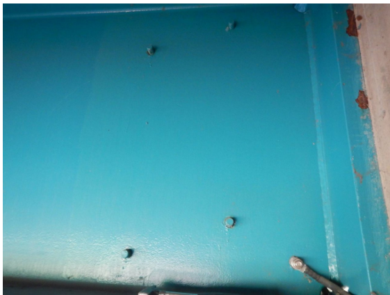
1839511_1_2018H_A20 3TER LT VON RECHTS MUTTERN FEHLEN
