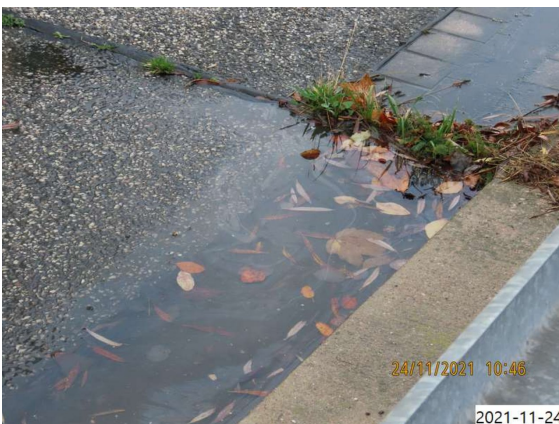
1839511_1_21E_ENTW-RINNE WASSERSTAU
