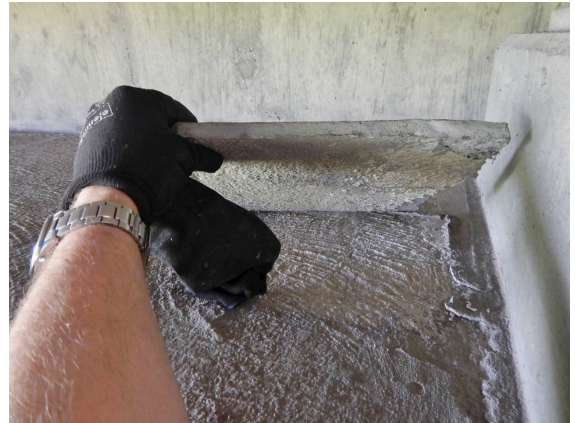
1839511_1_2018H_A20 MITTLERES LAGER PRESSENSTELLFLÄCHE
