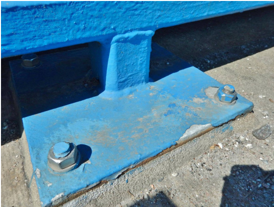
1839511_1_2018H_FÜLLSTABGELÄNDER ANKER GEKÜRZT
