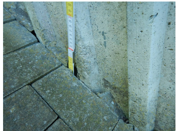
1839511_1_2018H_A10 FUGE NEBEN TRAUFPFLASTER
