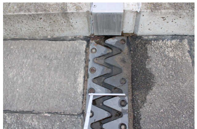
1645502_0_2021E_ÜKO SCHMUTZABLAGERUNG
