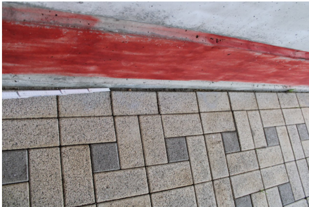
1645502_0_2021E_BÖSCHUNGSPFLASTER FUGEN OFFEN
