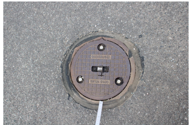
1645502_0_2021E_REINIGUNGSÖFFNUNG
