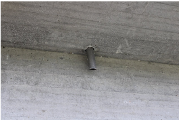
1645502_0_2021E_ROHRDUCHFÜHRUNG NICHT VERSCHLOSSEN
