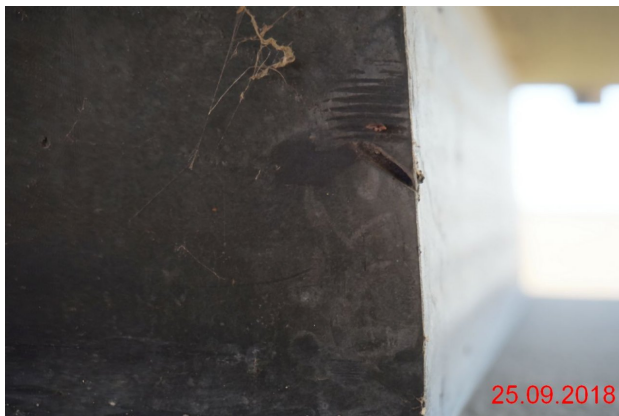
1645502_0_LAGERKISSEN ACHSE 20 EINGESCHNITTEN
