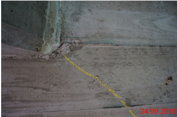
1645502_0_2018H2_QUERTRÄGER SCHRÄGRISSE
