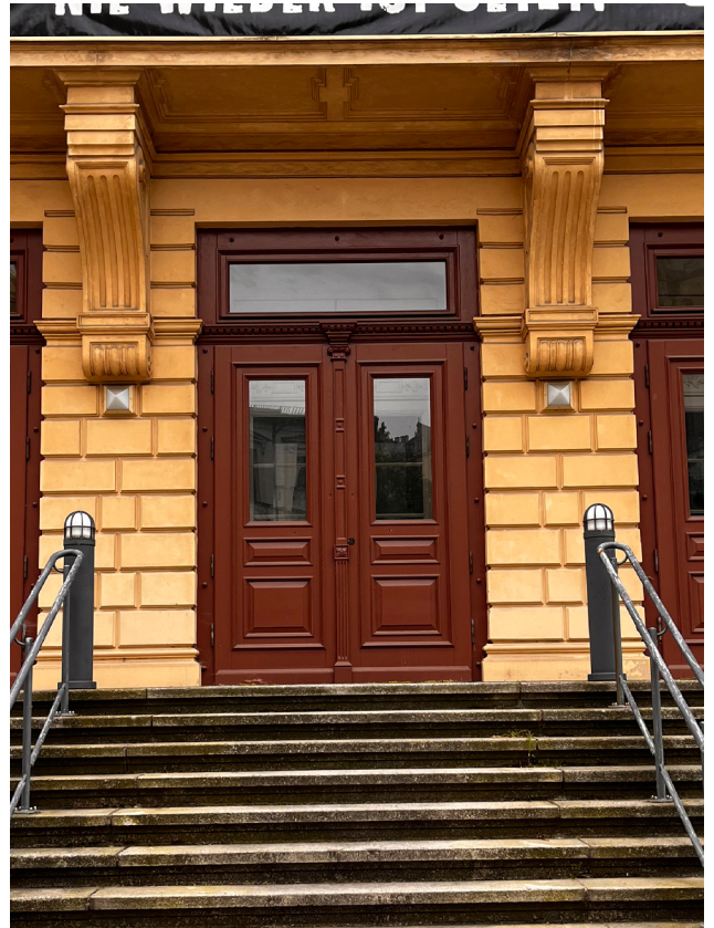
EG-T09 (von außen)
