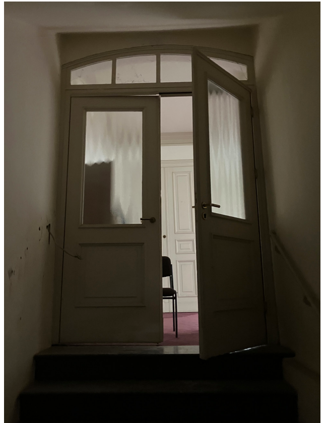
EG-T29 (von Treppenaufgang)
