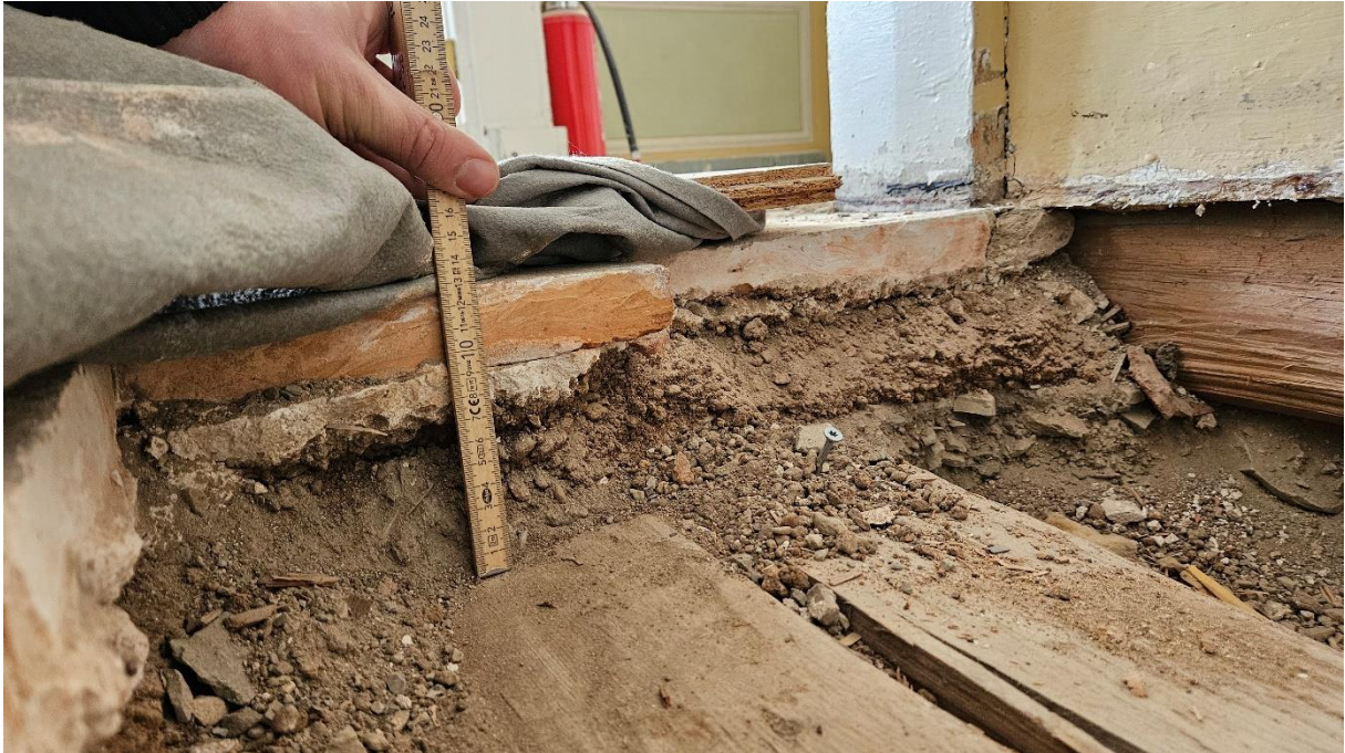
Abbildung 20: Raum 2.04, Innenwand, 7 cm Schüttung zwischen Deckenbalken und Estrich-Terrakotta-Belag.
