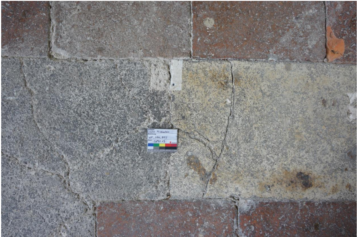
Abbildung 16: Raum 2.06. Unpassende Altergänzung (links).
