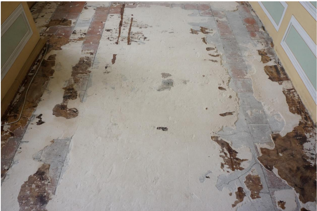
Abbildung 9: Raum 2.04. Nivelliermasse auf Estrichboden.
