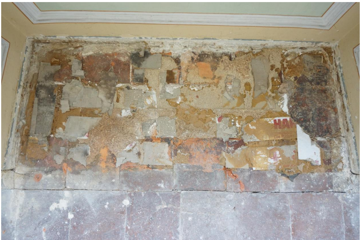
Abbildung 17: Raum 2.06. Anhaftende Beläge in Fensternische.
