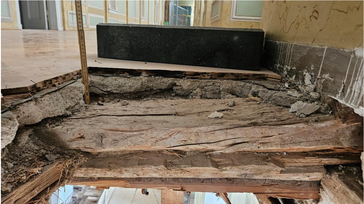
Abbildung 22: Raum 2.02 Fensterwand. Zementestrich mit Parkett.
