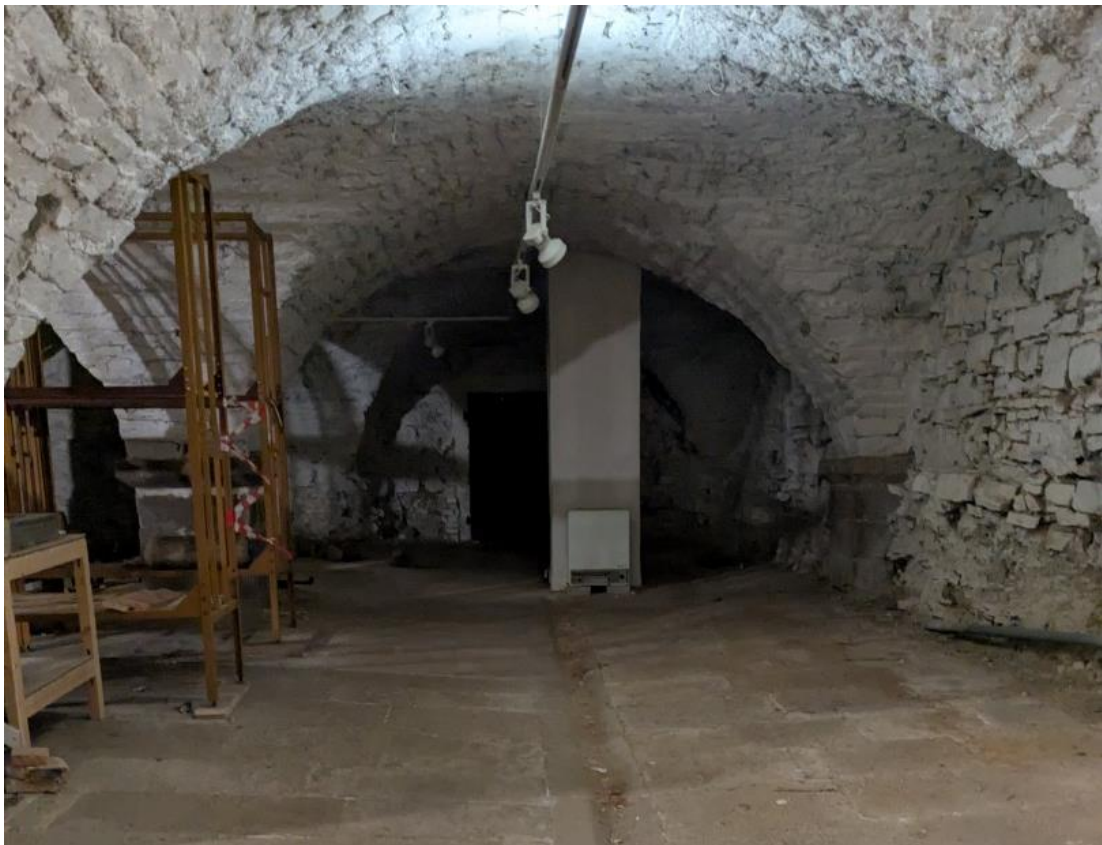
Abbildung 24, Abbildung 25, Abbildung 26: Westturm, Keller, Treppe von oben und unten gesehen, Kellergewölbe als Zwischendepot
