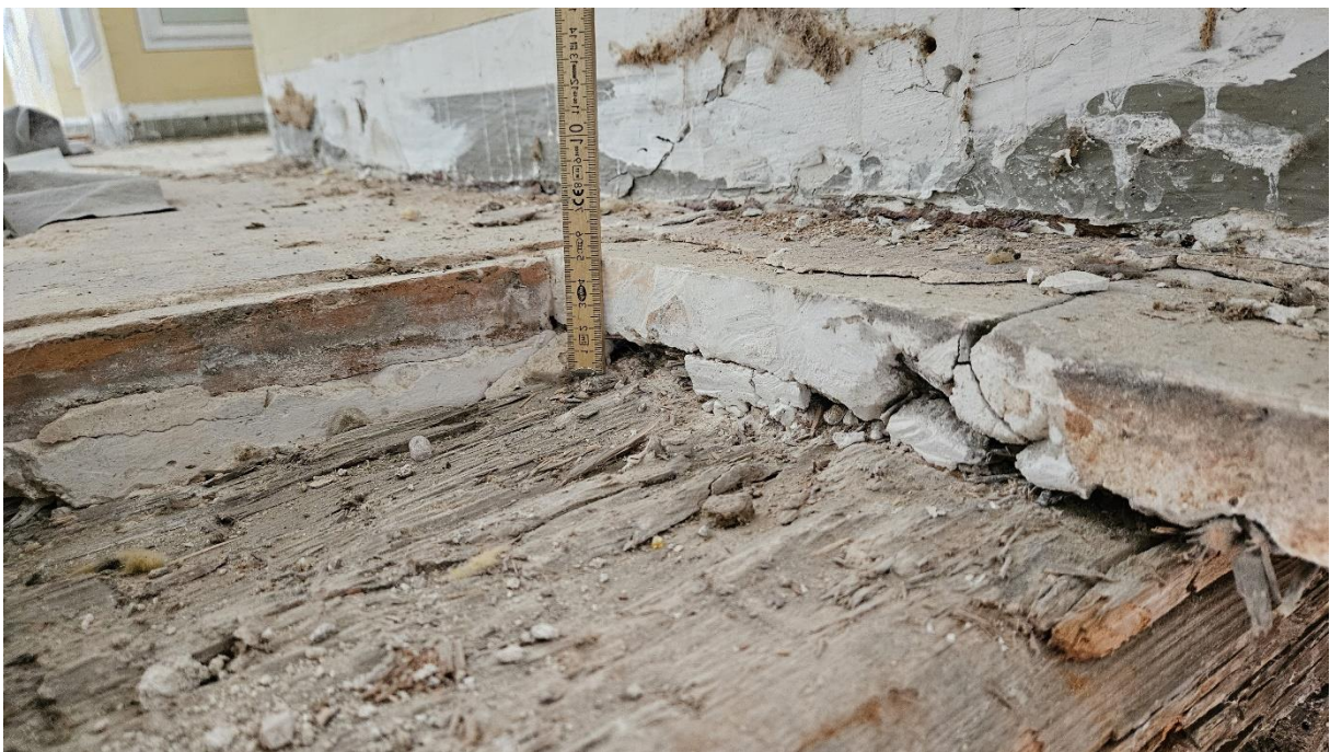
Abbildung 21: Raum 2.04, Fensterwand mit abgebeilten Deckenbalken. Ziegel mit dünner Setzmörtelschicht direkt auf Balken verlegt.
