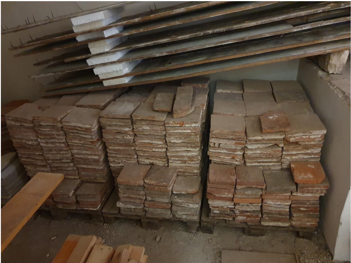
Abbildung 23: Westturm, Keller, eingelagerte Terrakottaplatten. Evtl. aus 2.02 stammend. Ca. 750 Stück.
