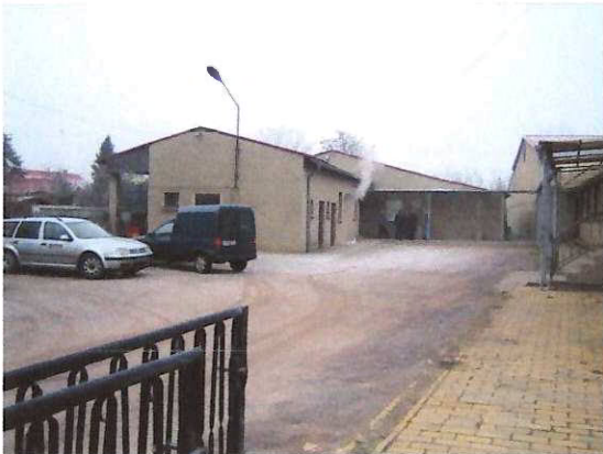
Freifläche Baustelleneinrichtung (Ostansicht)
