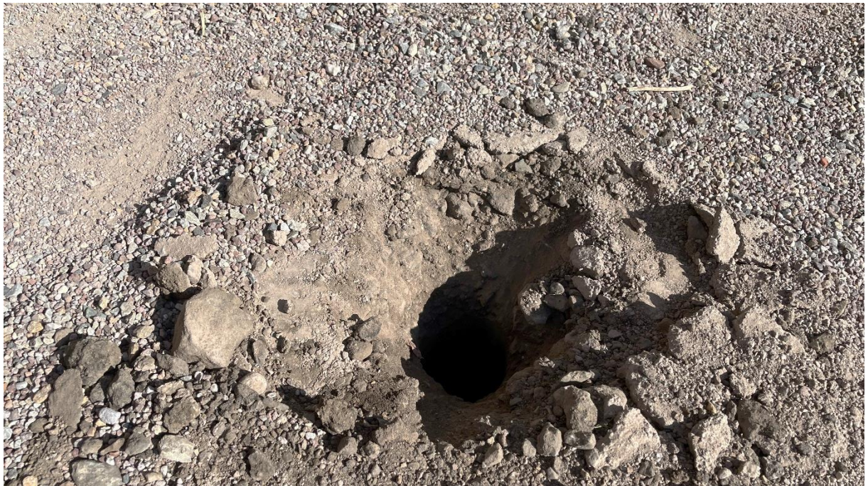
Abbildung 5: Auffüllung im Einfahrtbereich vom Herressener Weg
