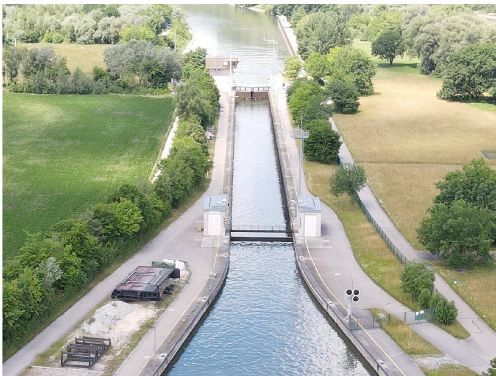
Schleuse Bad Abbach - Luftbild – Blick vom Oberwasser
