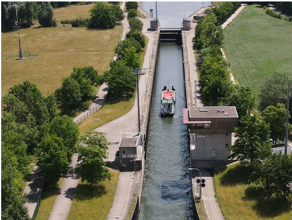
Schleuse Bad Abbach - Luftbild - Blick vom Unterwasser
