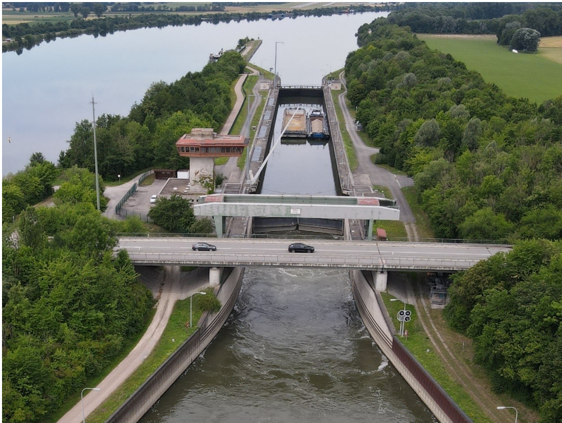
Schleuse Straubing - Luftbild - Blick vom Unterwasser
