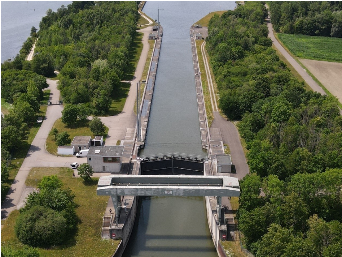
Schleuse Geisling - Luftbild - Blick vom Unterwasser
