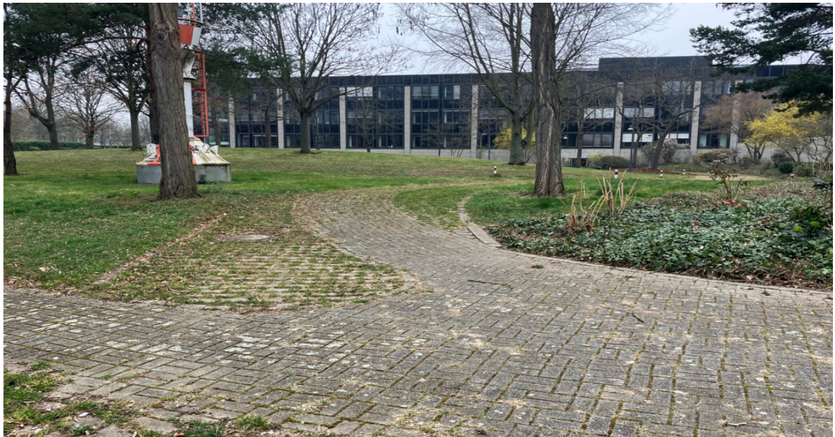
Zuwegung Verbundpflaster und Rasengittersteine
