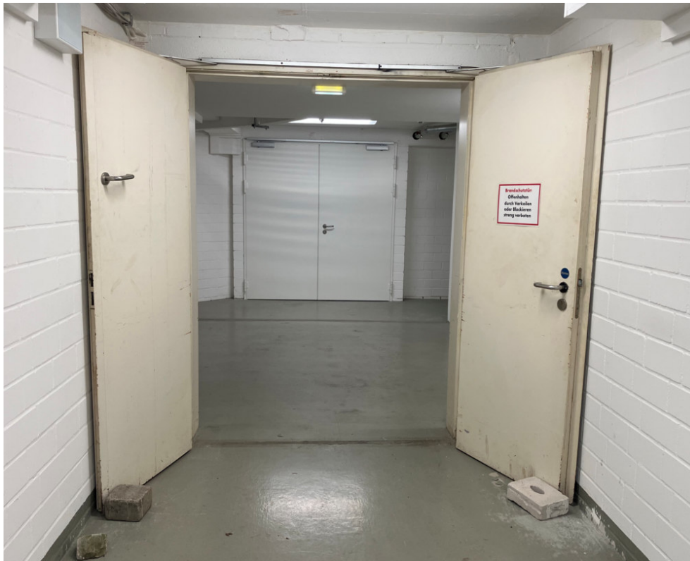
Zuwegung von Rampe zum Flur 1.UG
