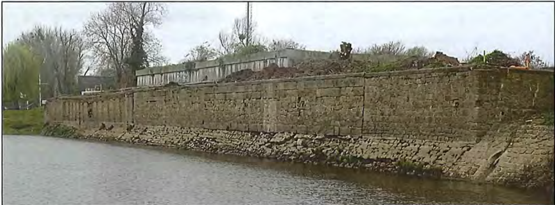
Abbildung 11: vorhandene, ehemalige Kaimauer
