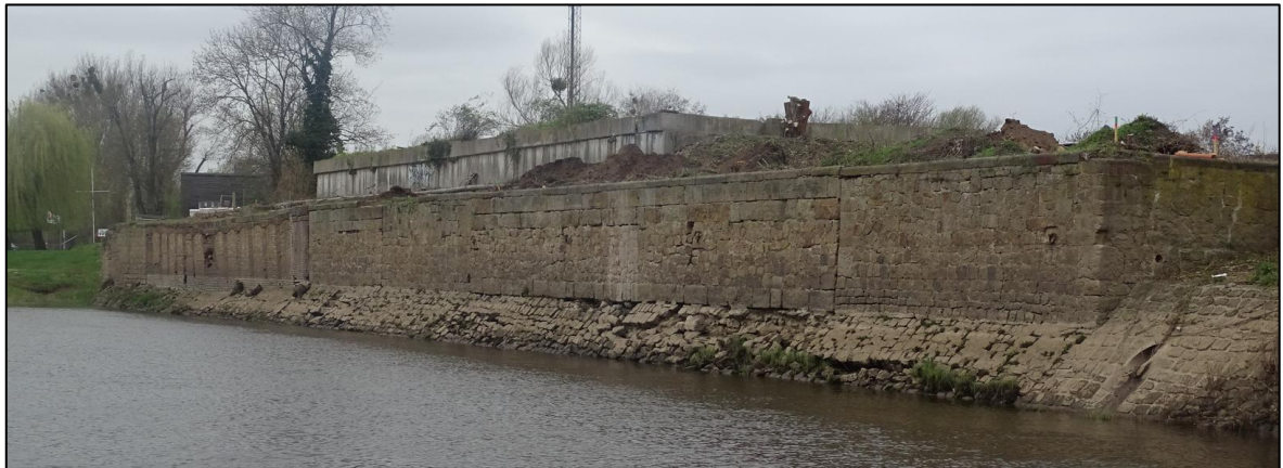
Abbildung 1: vorhandene, ehemalige Kaimauer
