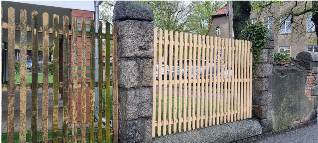
Die Mauer am historischen Einfahrtbereich ist im Bereich der Abdeckung, der Fugen und des Putzes beschädigt.
