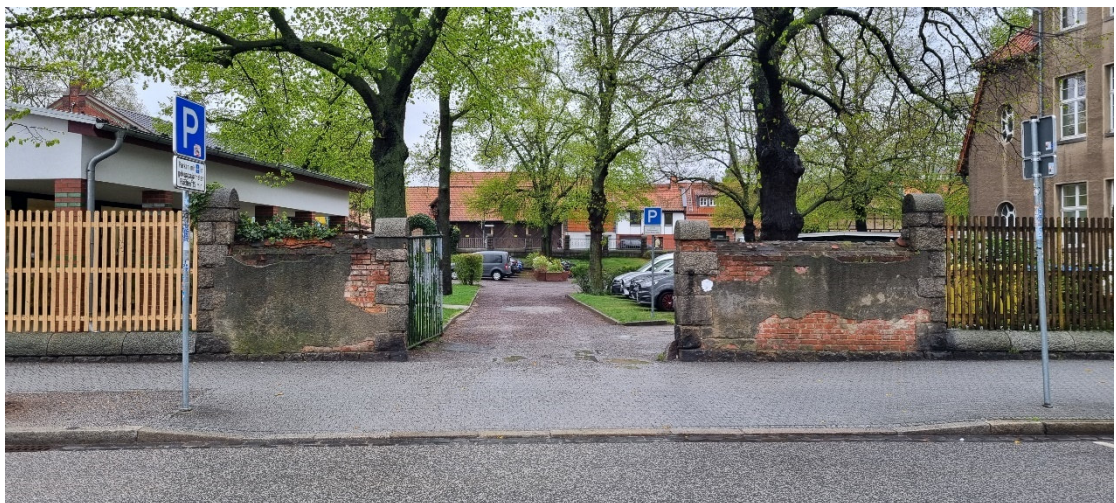
Die Mauer am historischen Einfahrtbereich ist im Bereich der Abdeckung, der Fugen und des Putzes beschädigt.
