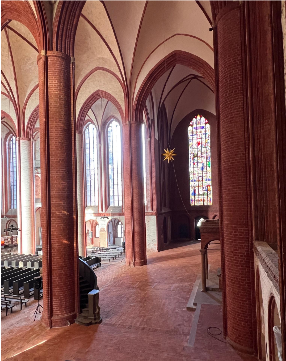
Blick ins Querhaus Nord (Zustand nach Sanierung 2.BA Querhaus Nord) Neuverlegung Ziegelpflaster Klosterformat im Querhaus
