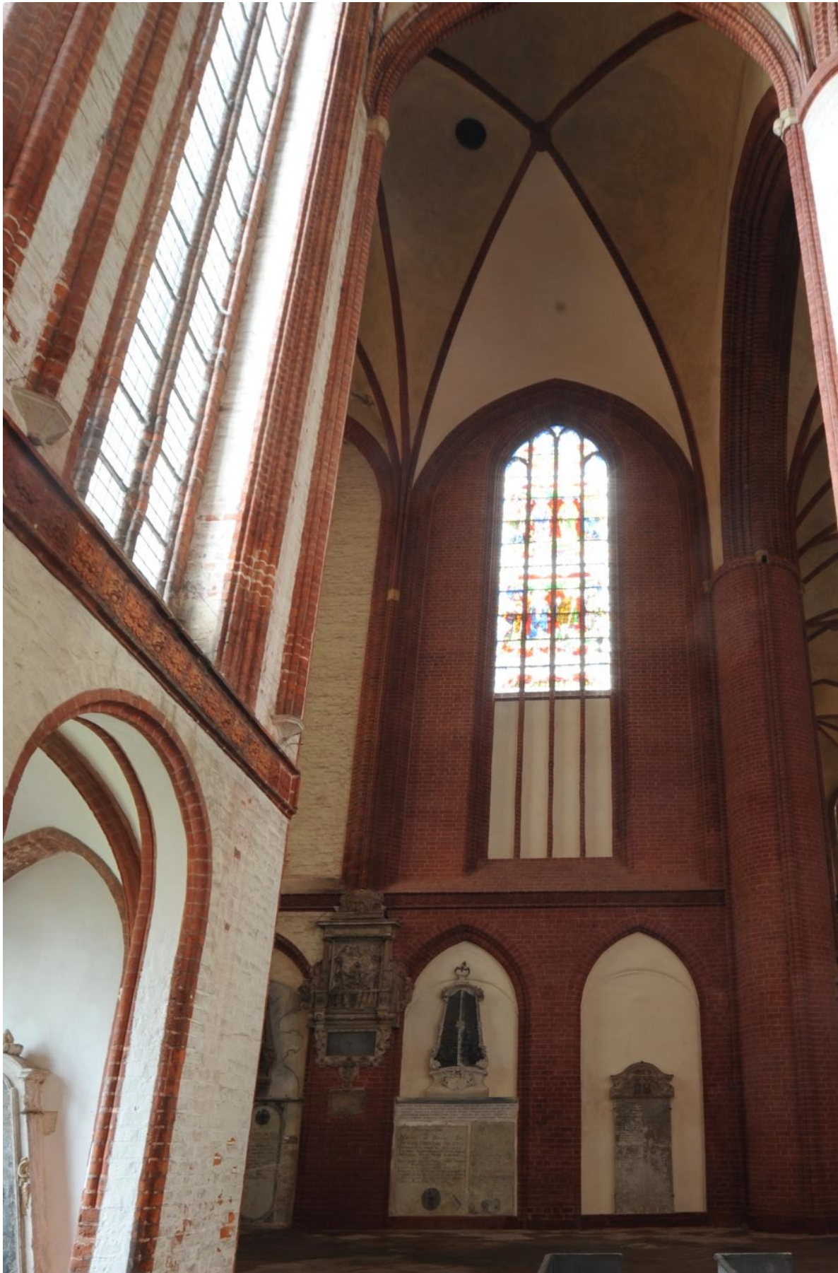
Blick v. Langhaus Nord auf Ostwand im Querhaus Nord (Musterachse Wand + Gewölbe + Vierungssäule)
