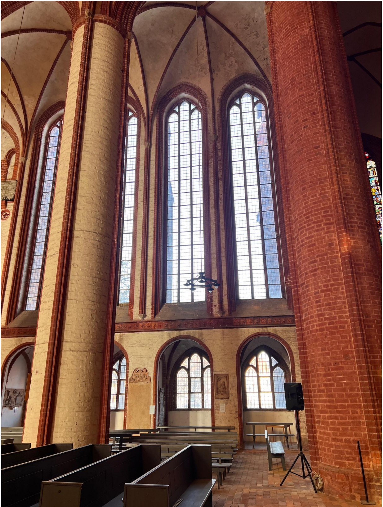
Langhaus Nordwand mit vorh. Weißfassung u. Vierungssäule mit neuer Rotfassung
