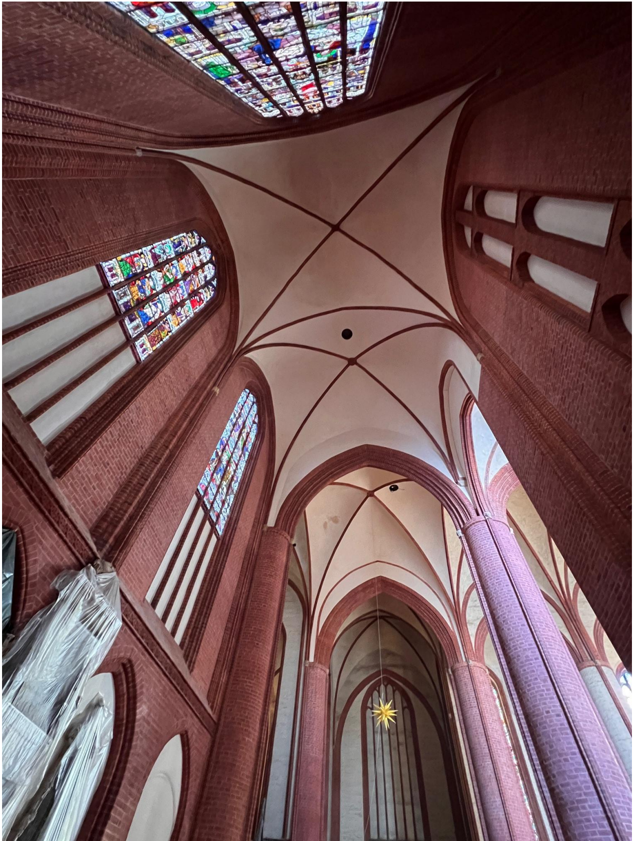
Nordquerhaus u. Vierung neue Rotfassung Wände u. Gewölbesanierung
