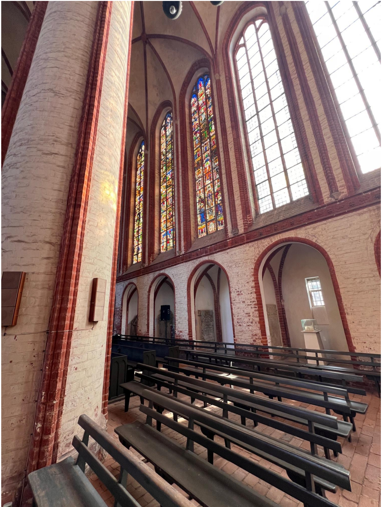
Langhaus Nordwand mit vorh. Weißfassung u. Seitenkapellen
