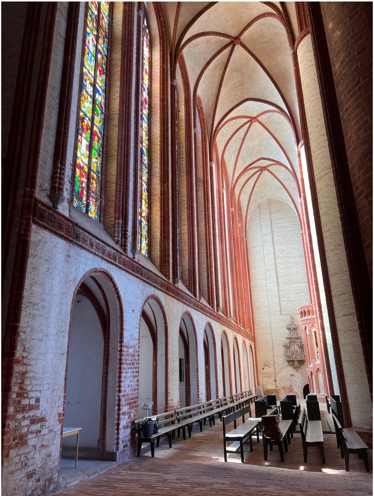
Langhaus Südwand mit vorh. Weißfassung u. Seitenkapellen
