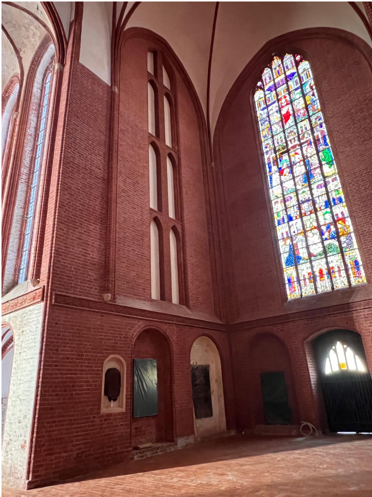
Nordquerhaus - neue Rotfassung Wände u. Bodenbelagserneuerung Ziegelpflaster
