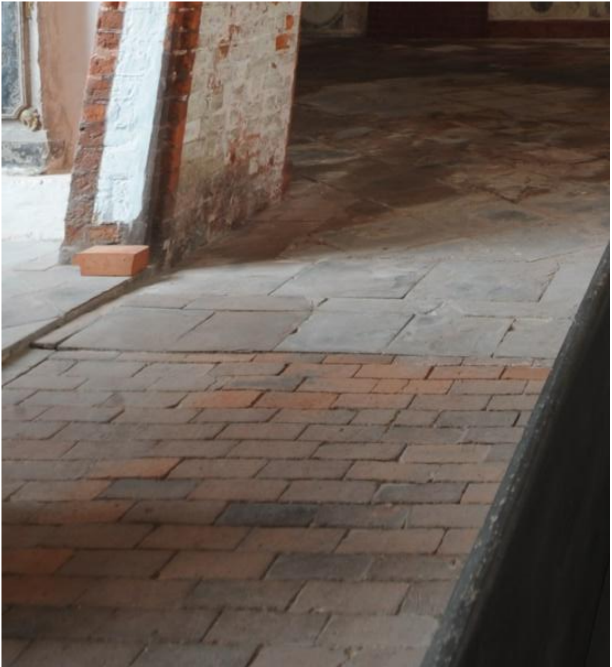
Langhaus Nord – vorh. Ziegelpflaster mit Sandsteinplatten (Zustand vor 2.BA)
