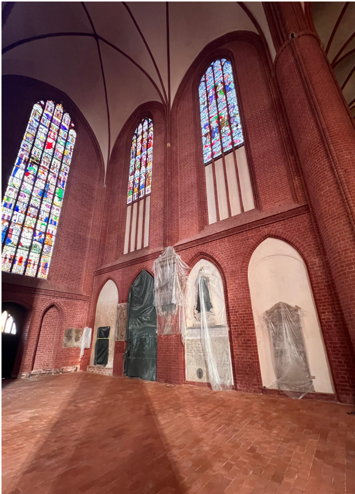
Nordquerhaus - neue Rotfassung Wände u. Gewölbesanierung u. Erneuerung Bodenbel.
