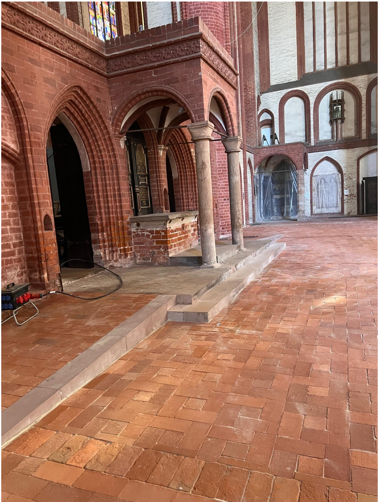
Lettner mit Rampen u. Neupflasterung Vierungsbereich
