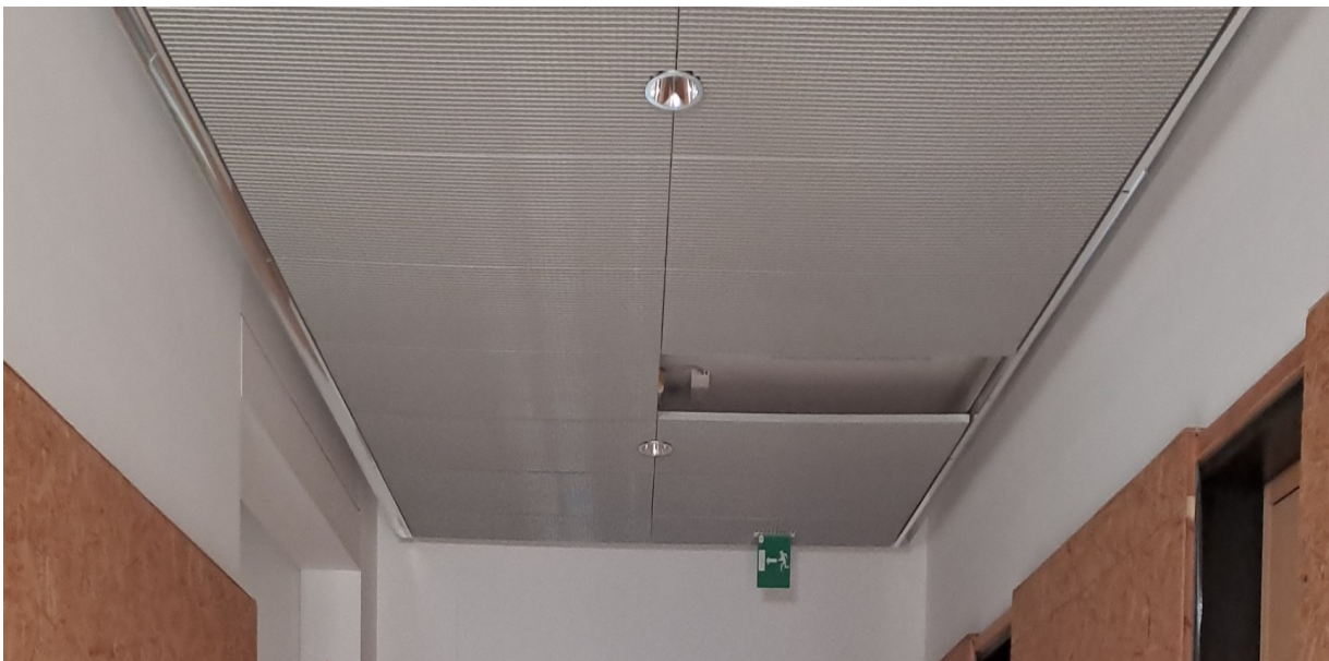
Abb. 9 Rasterdecke mit seiltichen Leuchtenleisten, Bestand
