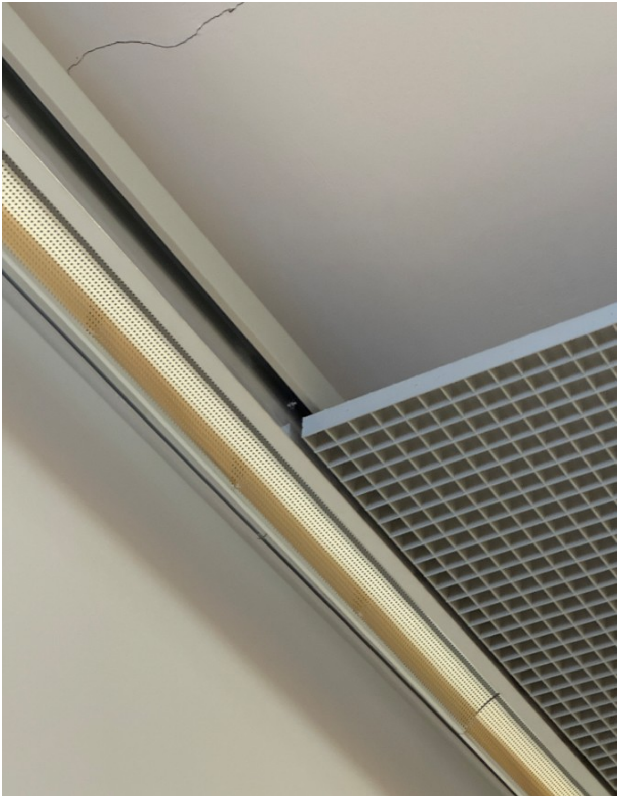
Abb. 11 Rasterdecke Deckenrand mit U-Schiene und Leuchte, Bestand
