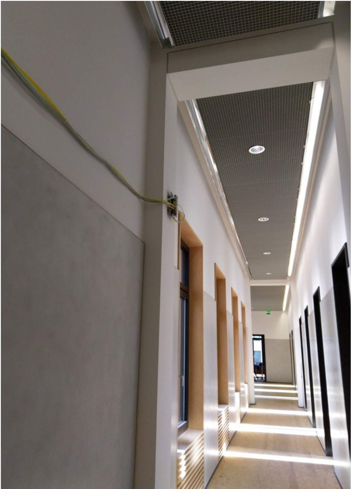
Abb. 10 Rasterdecke mit seitlicher Leuchtenleiste und eingebauten Punktleuchten im Flur
