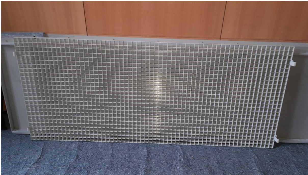
Abb. 12 ausgebautes Rasterdeckenelement Bestand
