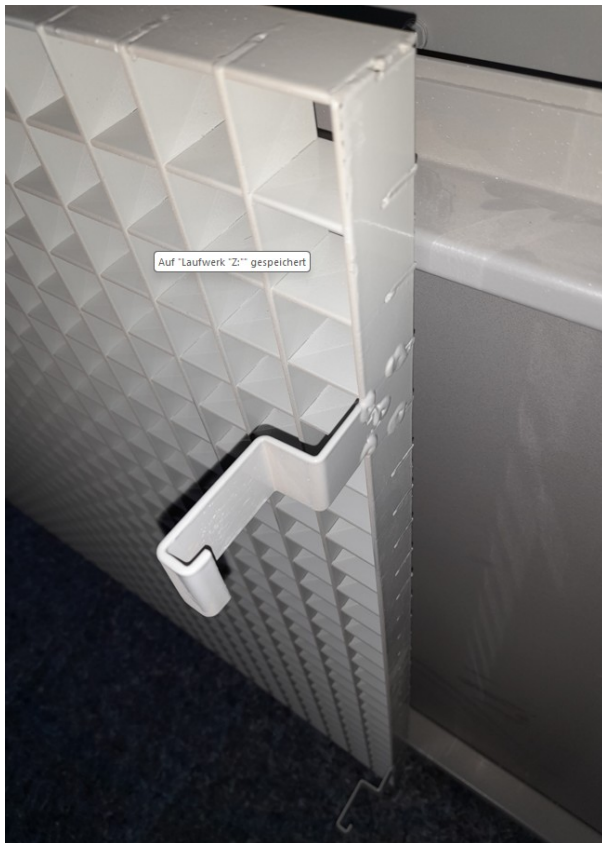
Abb. 13 Detail Aufhängung Rasterdecke Bestand
