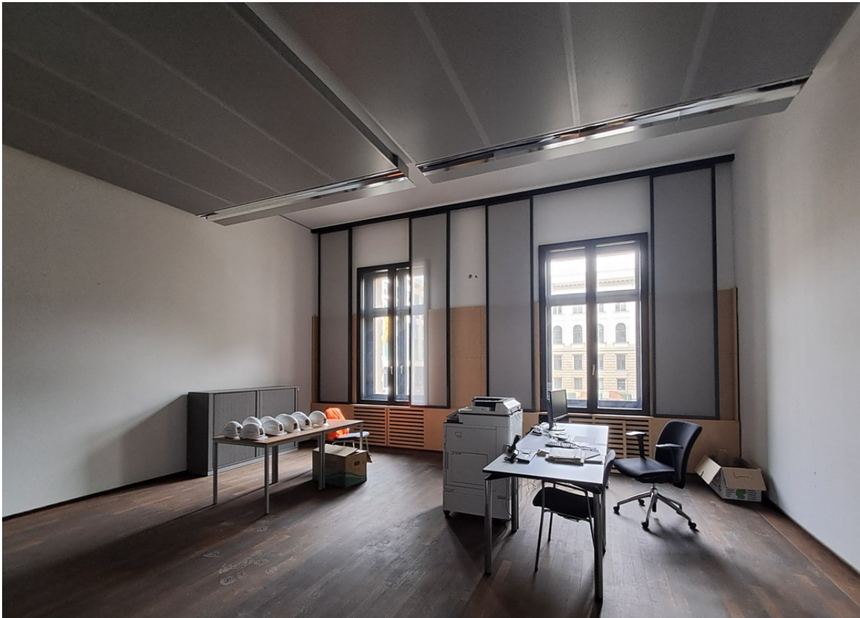
Abb. 3 Büroraum, Decke mit Metaldeckenpaneelen perforiert und Beleuchtung
