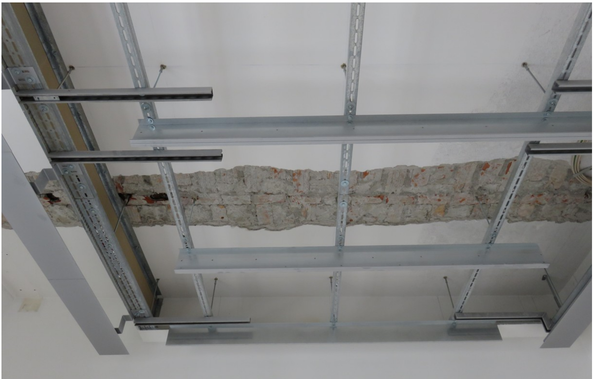
Abb. 7 Büroraum, ausgebaute Metalldeckenpaneelen und ausgebaute Beleuchtung
