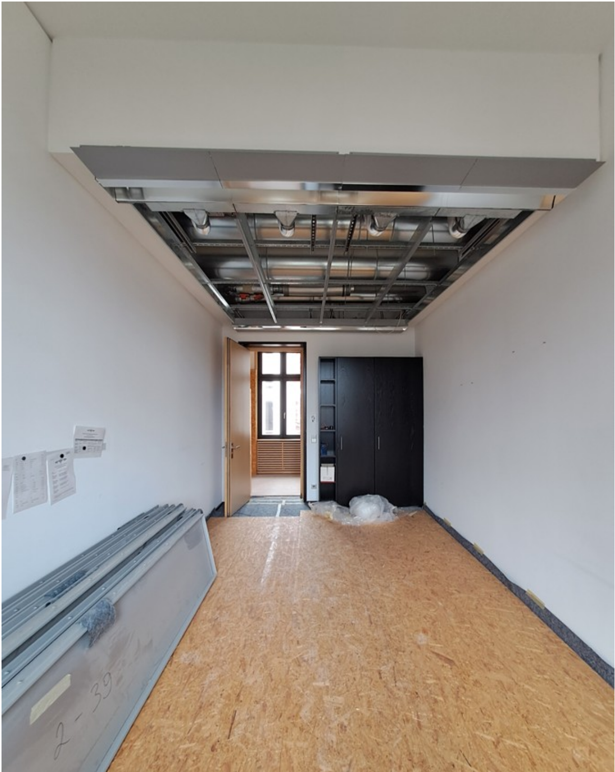
Abb. 5 Büroraum, ausbaute Metaldeckenpaneelen, zwischengelagert im Raum (aktueller Zustand)
