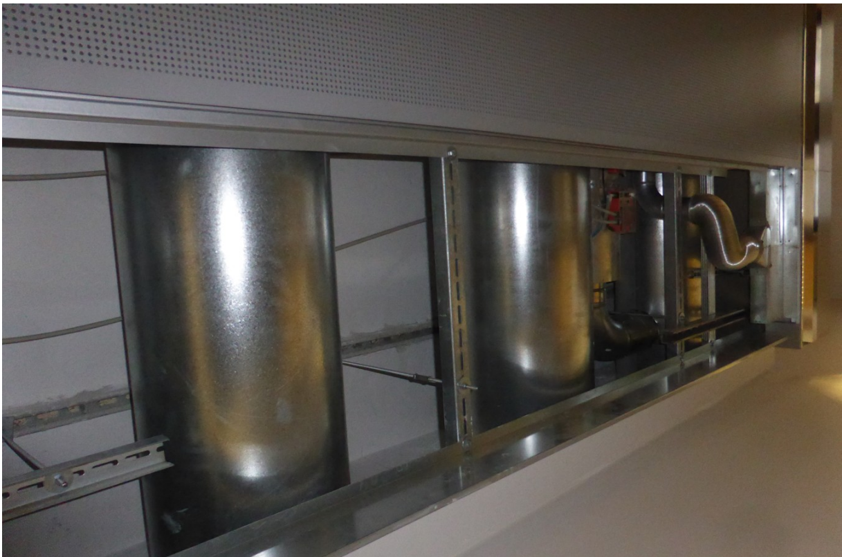
Abb. 4 Decke mit Metaldeckenpaneelen perforiert, ausgebaut
