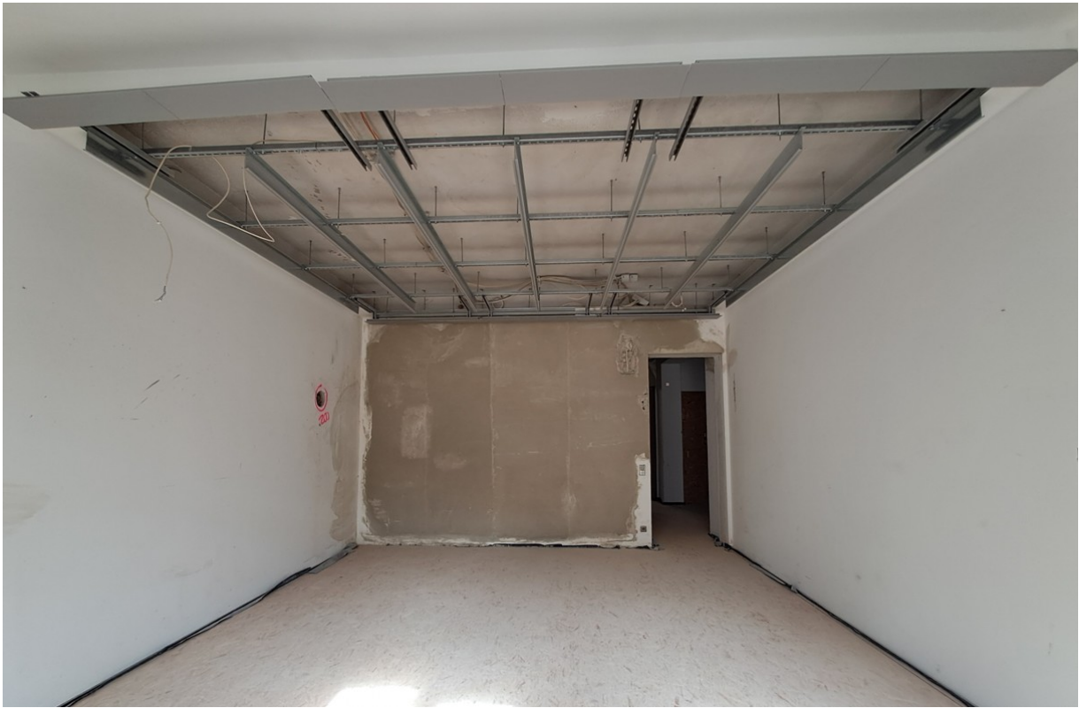
Abb. 6 Büroraum, ausgebaute Metalldeckenpaneelen und ausgebaute Beleuchtung
