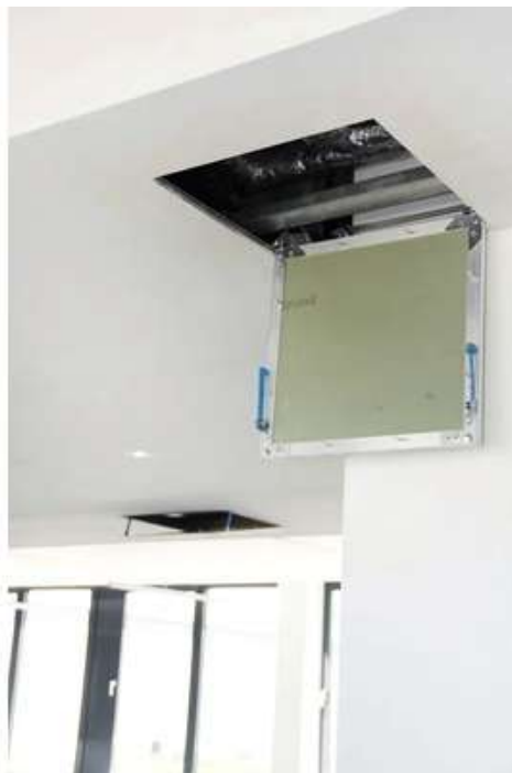
Abbildung 7: Beispiel für eine Revisionsöffnung für Deckenkomponenten
