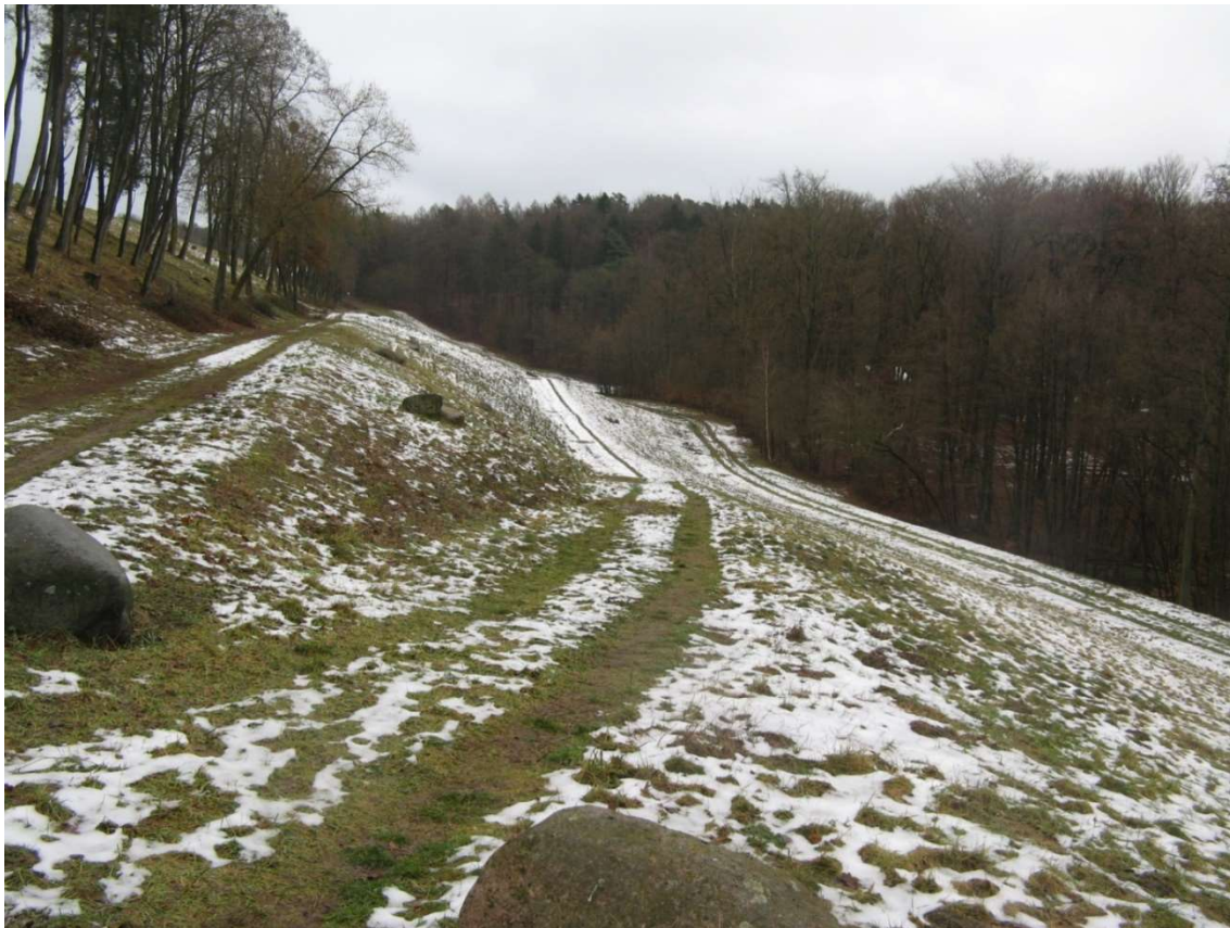
Bild 2 – Ragöser Damm Südseite, Aufnahme vom 07.01.2021
