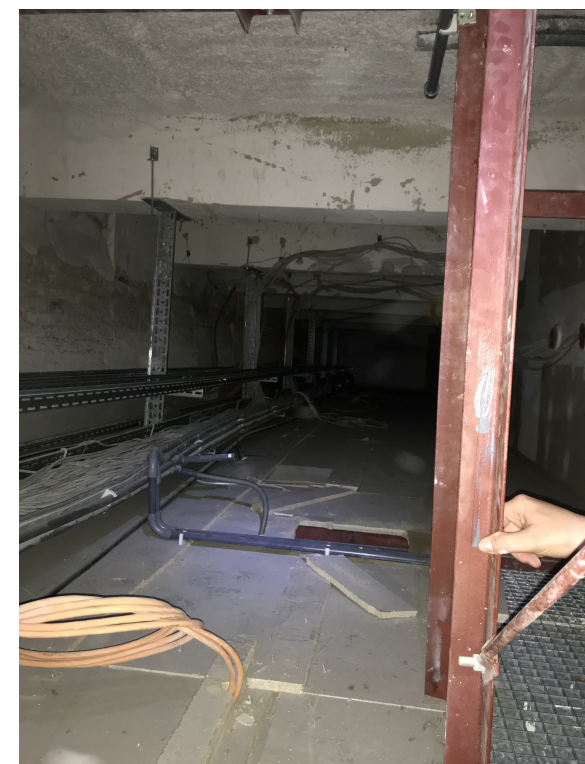
Bild 2: Blick Ende Bestandssteg
