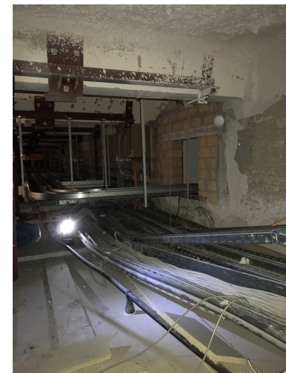
Bild 1: Blick Richtung Bestandsanlage
