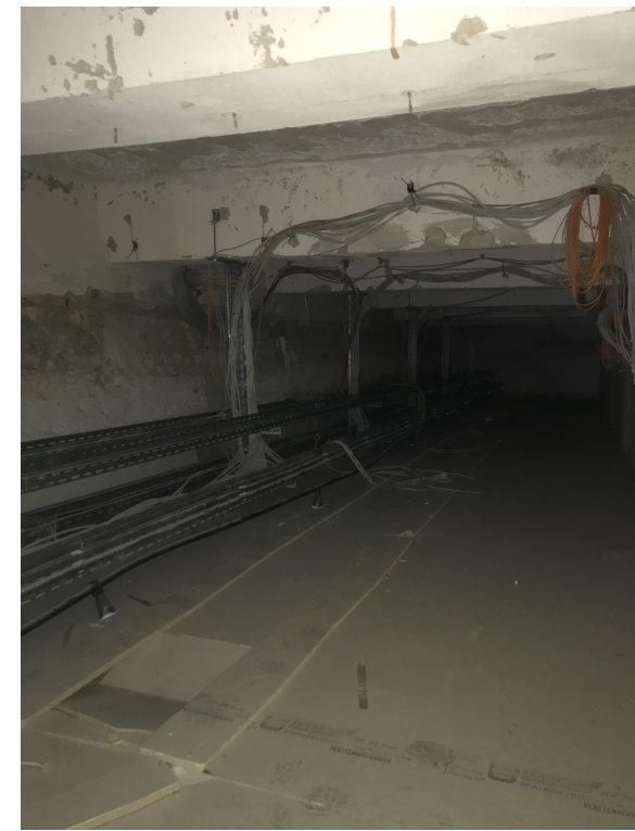
Bild 4: Blick zu erschließ. Deckenhohlraum
