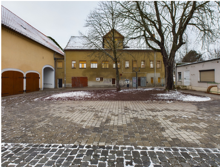
Foto: Bestandsgebäude Altmarkt 11a vor Rückbau
