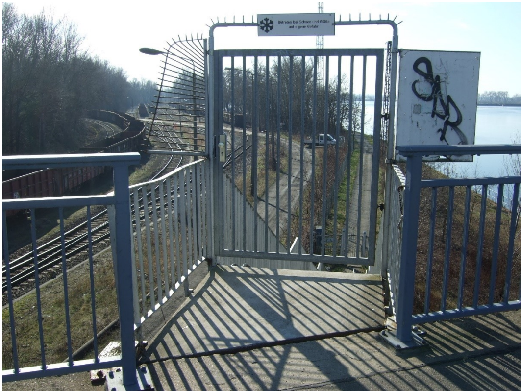
Zugang zur Treppenanlage vom Bestandsüberbau aus
