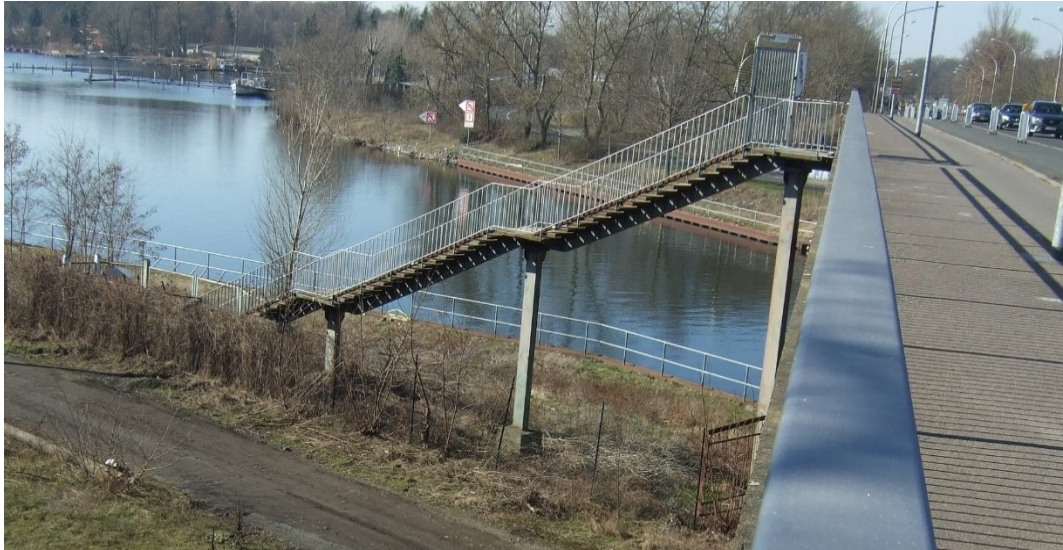
Treppenanlage im Bestand
