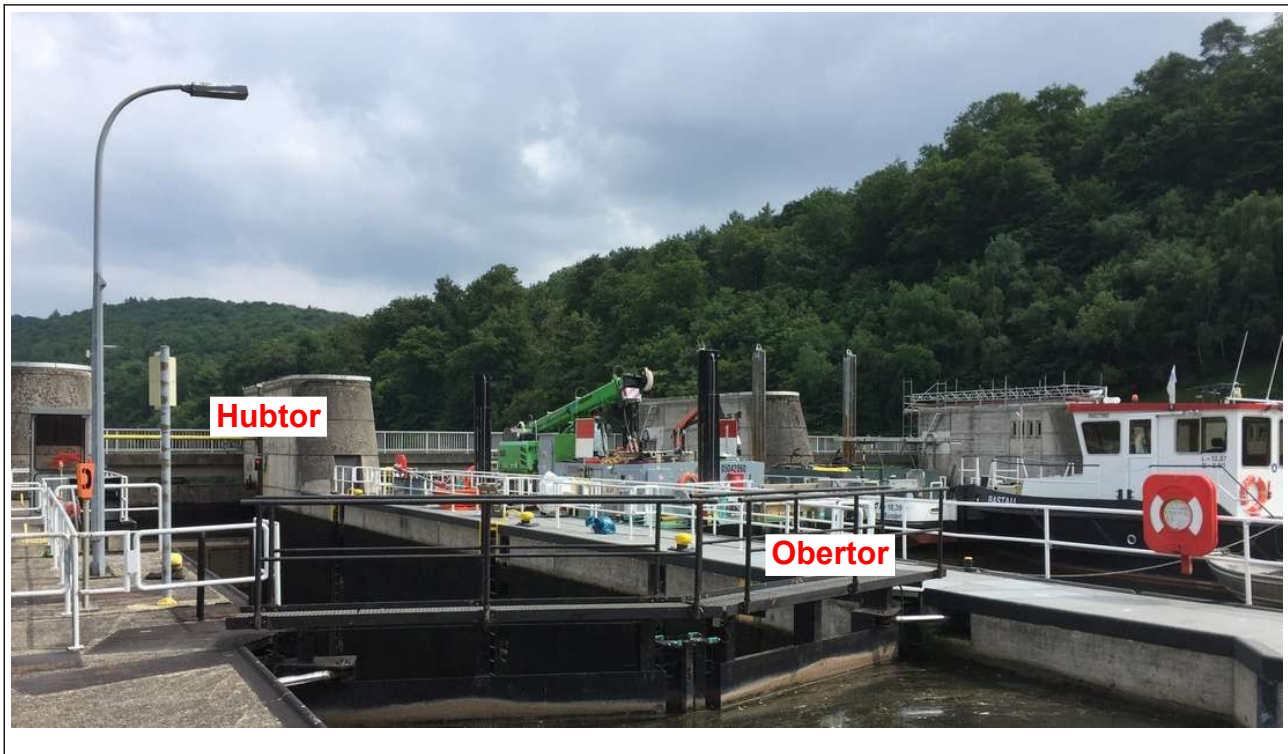
Abb. 1: Ansicht Schleuse Wahnhäuser
