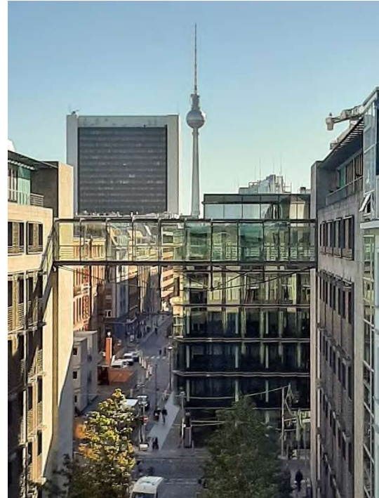
Brücke Jakob-Kaiser-Haus 4-8 (Ansicht Richtung Osten)
