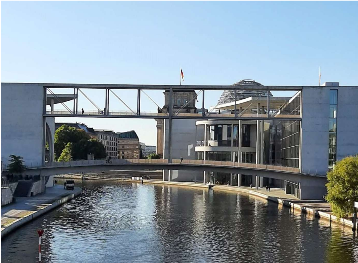
Brücken über die Spree (Ansicht Richtung Süden)
