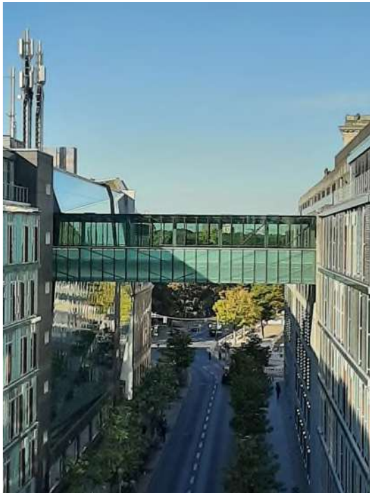
Brücke Jakob-Kaiser-Haus 2-6 (Ansicht Richtung Westen)
