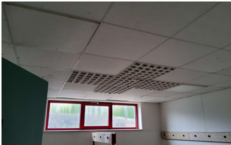
Beispiel: Decke Umkleide
