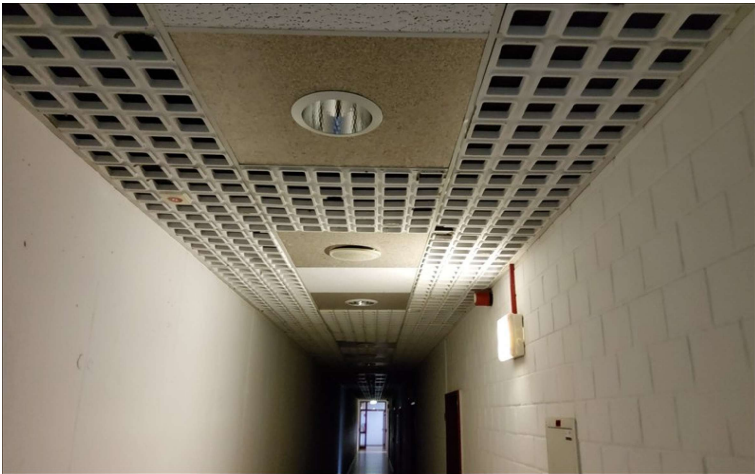
Beispiel Decke Flur
