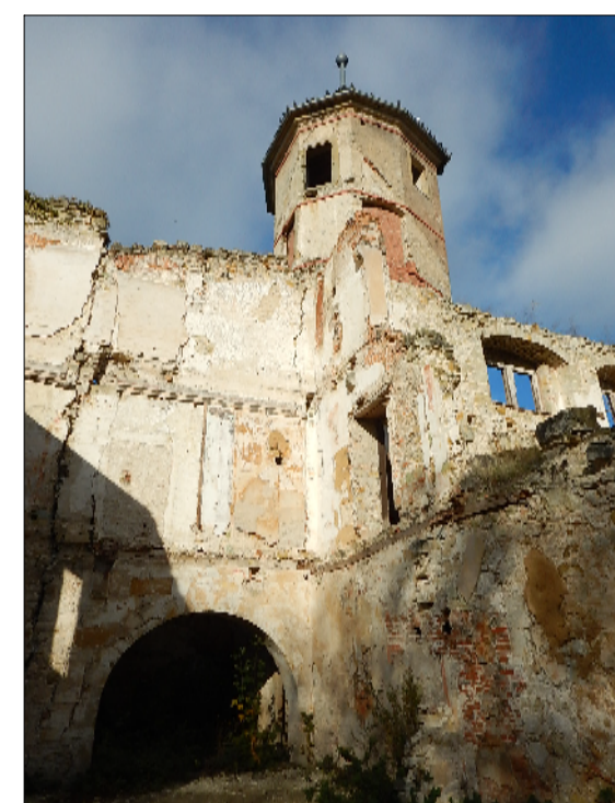
Sanierung des Turmes
