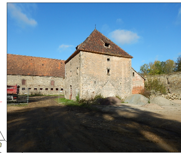
Außenanlagen und PP-WC
