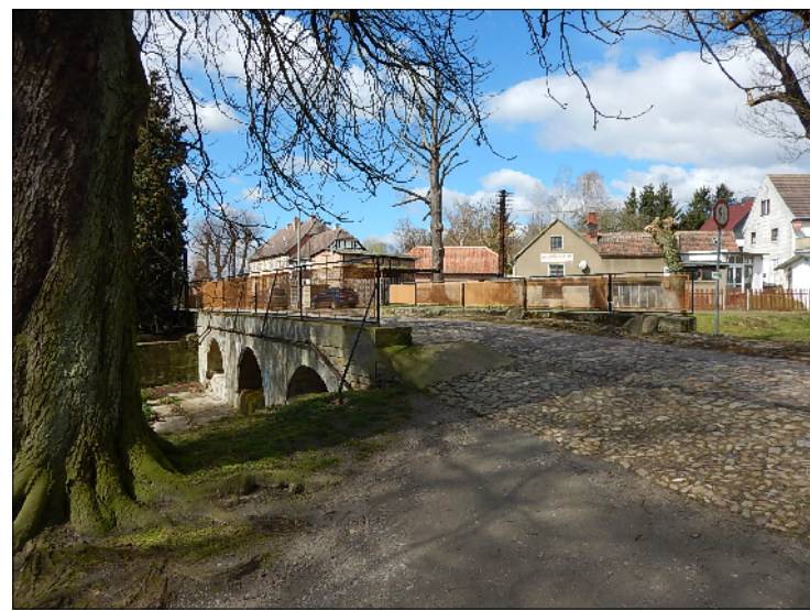
Sanierung der westlichen Steinbrücke Größe ca. 8 m x 15 m für Schwerlasttransport
