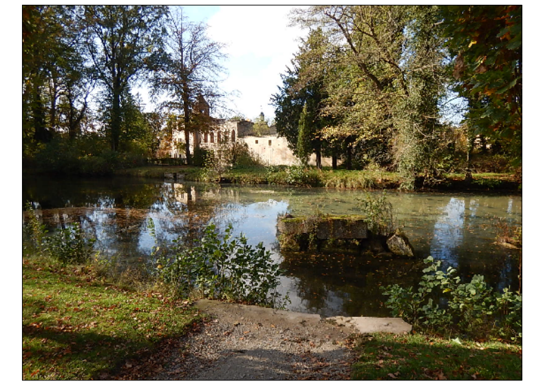
Wiederherstellen der östlichen Holzbrücke mit Stahlgeländer Größe ca. 2,55 m x 28 m
