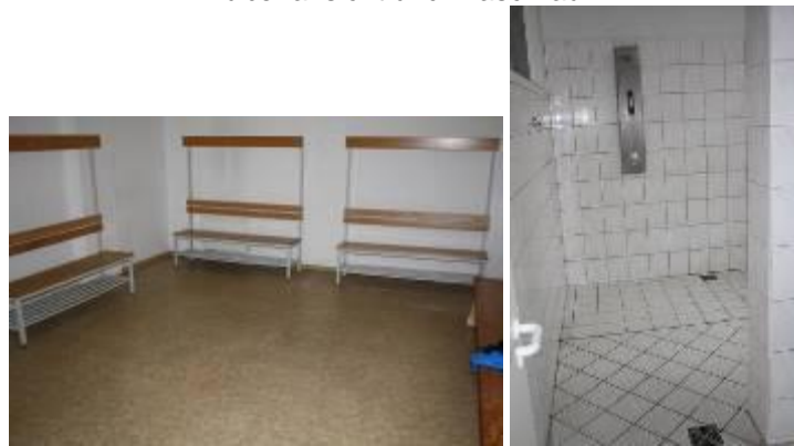
Umkleieraum, Dusche und Turnhalle
