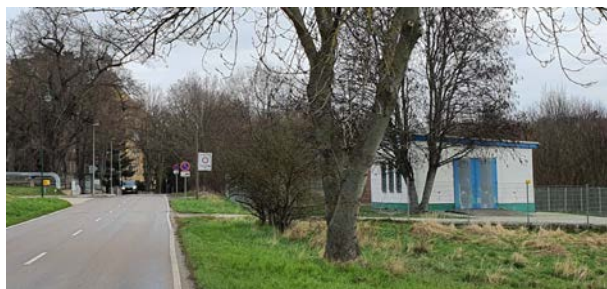
Bild 1.1: südl. Trasse, Gasregelstation bis Einmündung Südring (von links), Blickrichtung Nord
