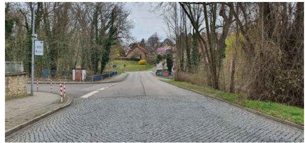
Bild 1.4: Übergang am nördl. Trassenabschnitt Einmündung Hochheimweg (von links), Blickrichtung Nord
