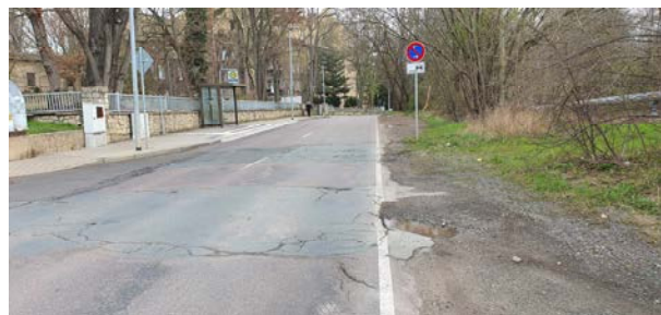
Bild 1.2: südliche Trasse, nördlich Einmündung Südring bis nördlich Bushaltestelle Blickrichtung Nord
