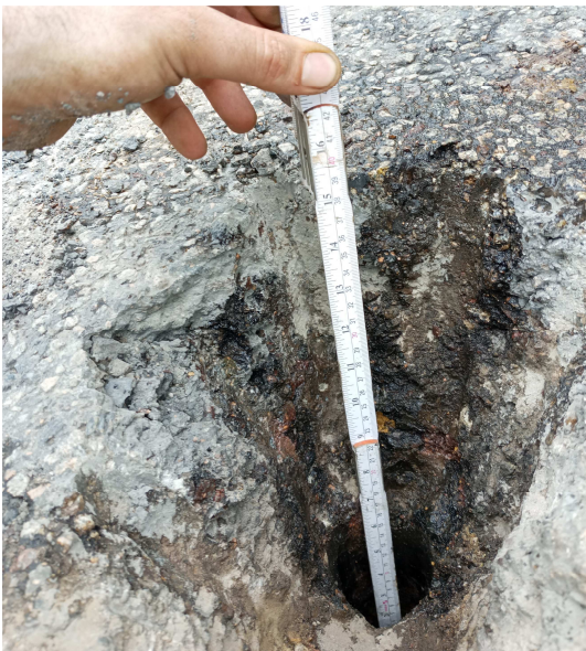
Bild 1.1: Aufbruch Schwarzdecke - BS 5
