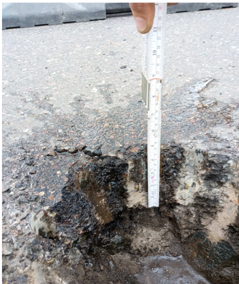
Bild 4.1: Aufbruch Schwarzdecke - BS 8
