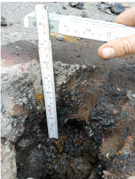
Bild 3.1: Aufbruch Schwarzdecke - BS 7
