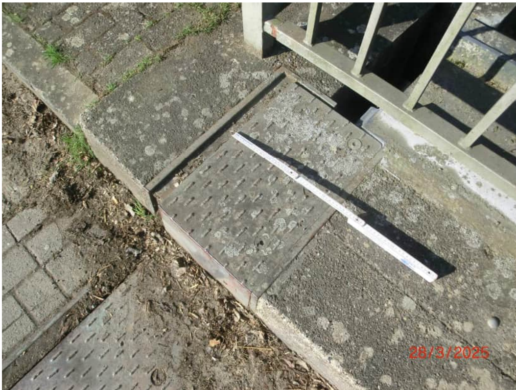
Abdeckblech mit angrenzendem Geländer
