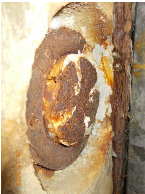
Ankerköpfe Längsvorspannung der Fahrbahnplatte
