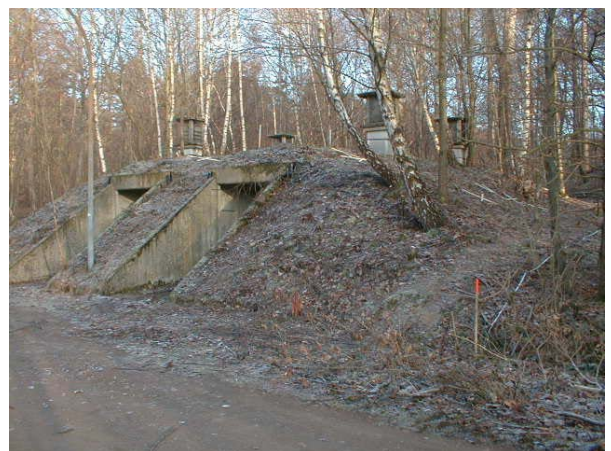
Abb. A-3.1-34 Untersuchungsfläche, Bereich des ehemaligen Munitionsbunkers (Foto: Krummel)
