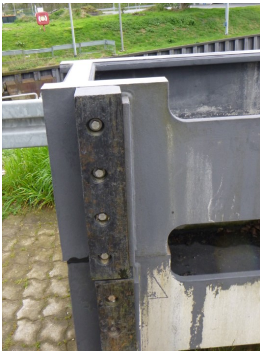
Abbildung 3 Ansicht Dammbalkenaufleger
