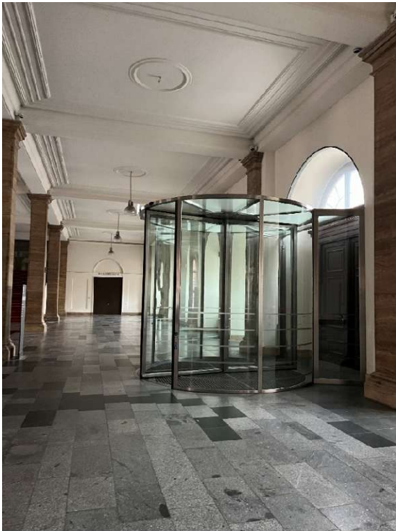
Schutz Rondelltür, Glaskonstruktion
