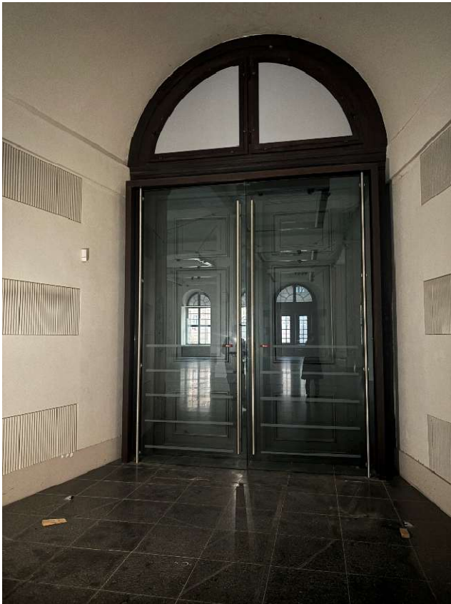
Demontage Zugangstüren Glas
