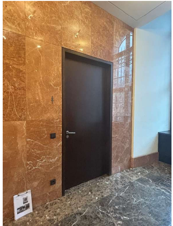
Zugangstüren WC Damen und Herren
