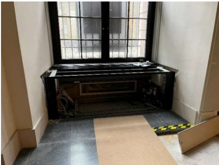
Einhausung NKG Erdgeschoss Standard, Demontage
