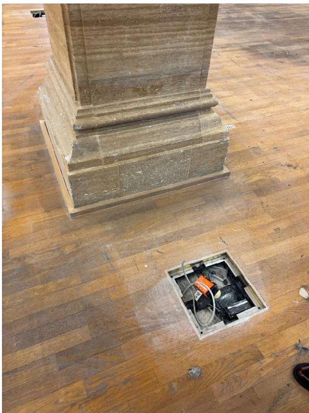
Travertin Sockelbereiche Stützen
