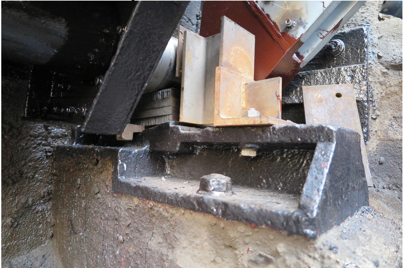
Lagesicherung Klapptorlagerung Schleuse Wusterwitz
