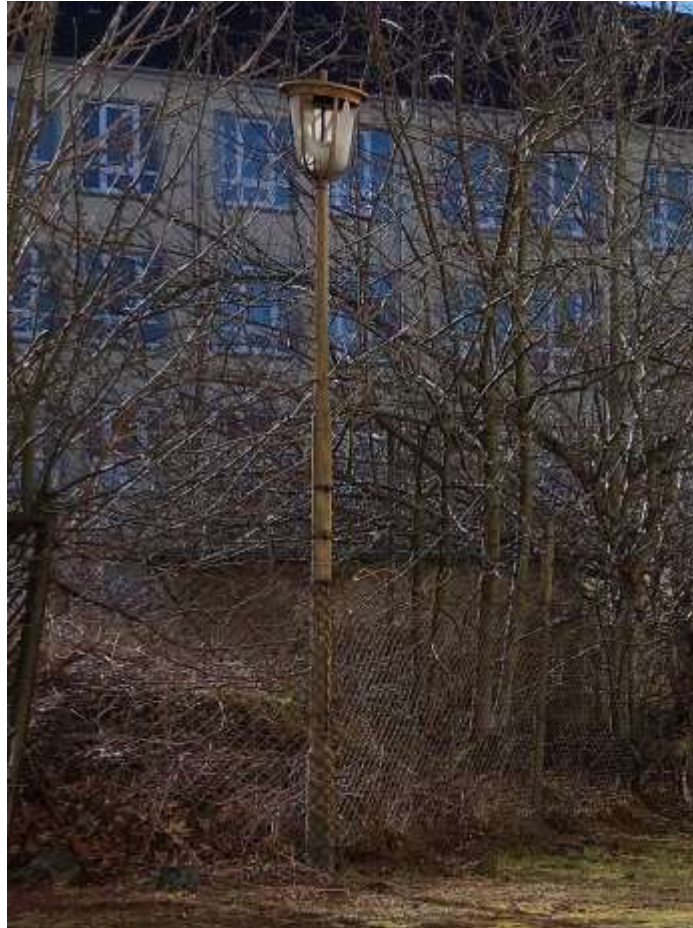
AVV 160214 Leuchte AVV 170411 Leitungen AVV 170405 Mast
