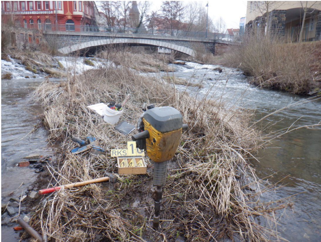
Abb. 2: Brücke von unterhalb des Wehres gesehen
