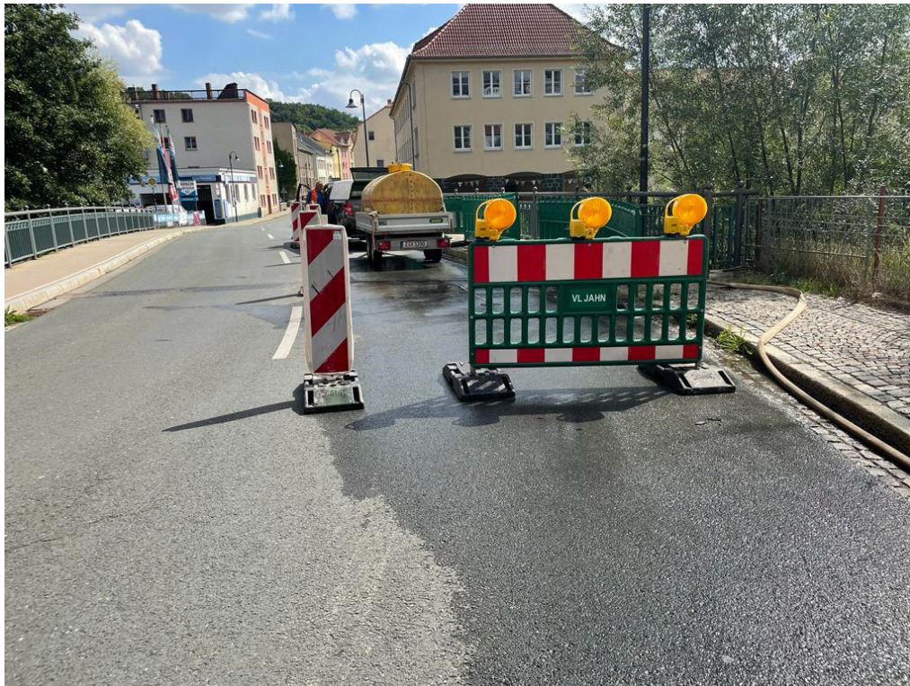
Abb. 3: Verkehrssicherung / Baustelleneinrichtung – KB 1, KB 1a, KB 1b
