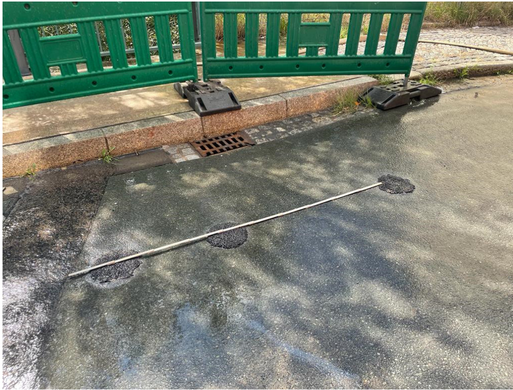
Abb. 1: Lage / verschlossene Ansatzpunkte – KB 1b, KB 1a, KB 1 (von links nach rechts)
