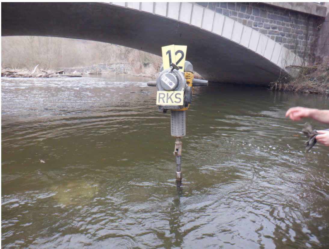
Abb. 3: nördliches Widerlager stromaufwärts
