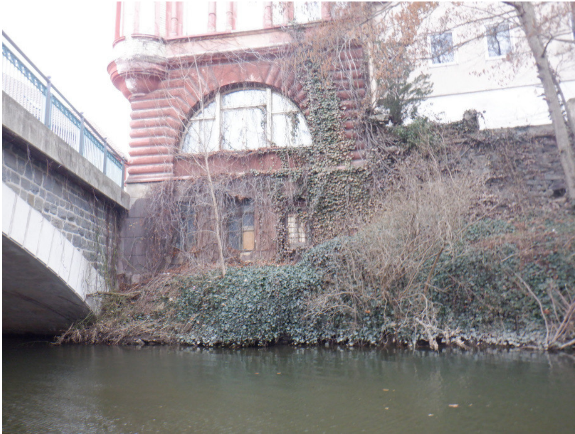
Abb. 2: Gebäude Gräfenbrücker Straße 1a, wasserseitige Hauswand unmittelbar an der Brücke
