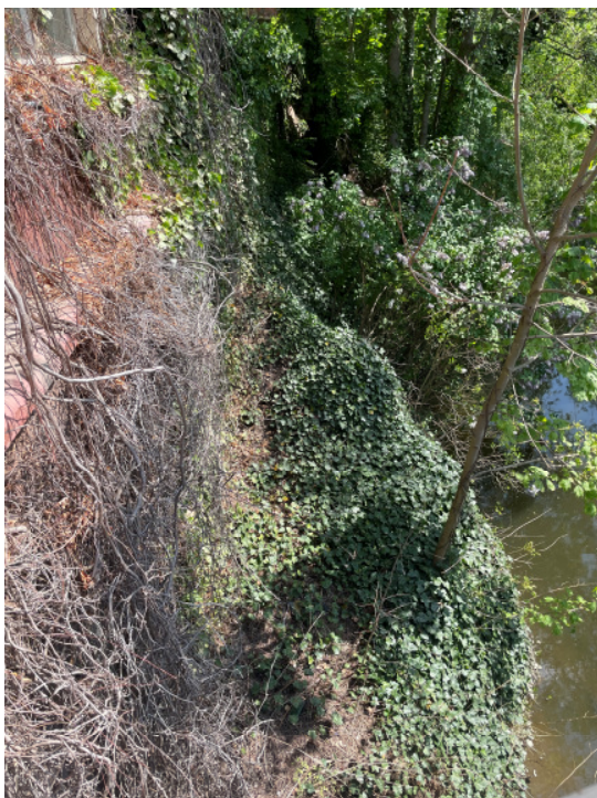
Abb. 3: Gebäude Gräfenbrücker Straße 1a, wasserseitige Hauswand unmittelbar an der Weida
