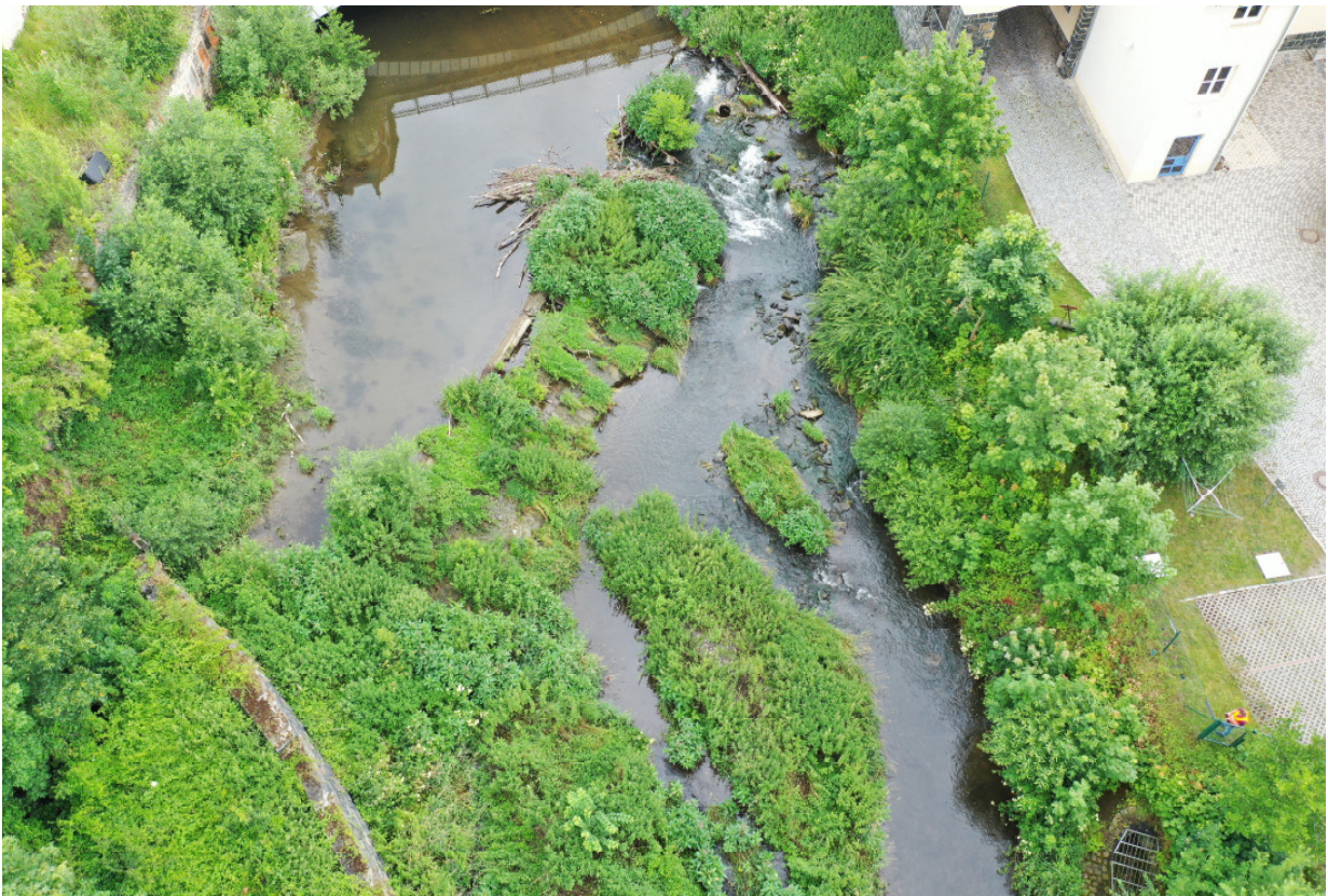
Abb. 1: Katschmühlenwehr in Weida, Draufsicht
