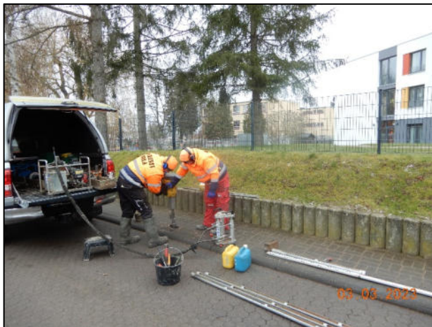
Durchführung der Kleinrammbohrungen (KRB) Oben KRB 1; rechts KRB 2; unten KRB 3
