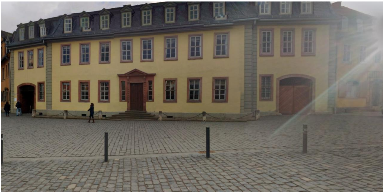
Bild 1: Ansicht, Quelle Google maps
