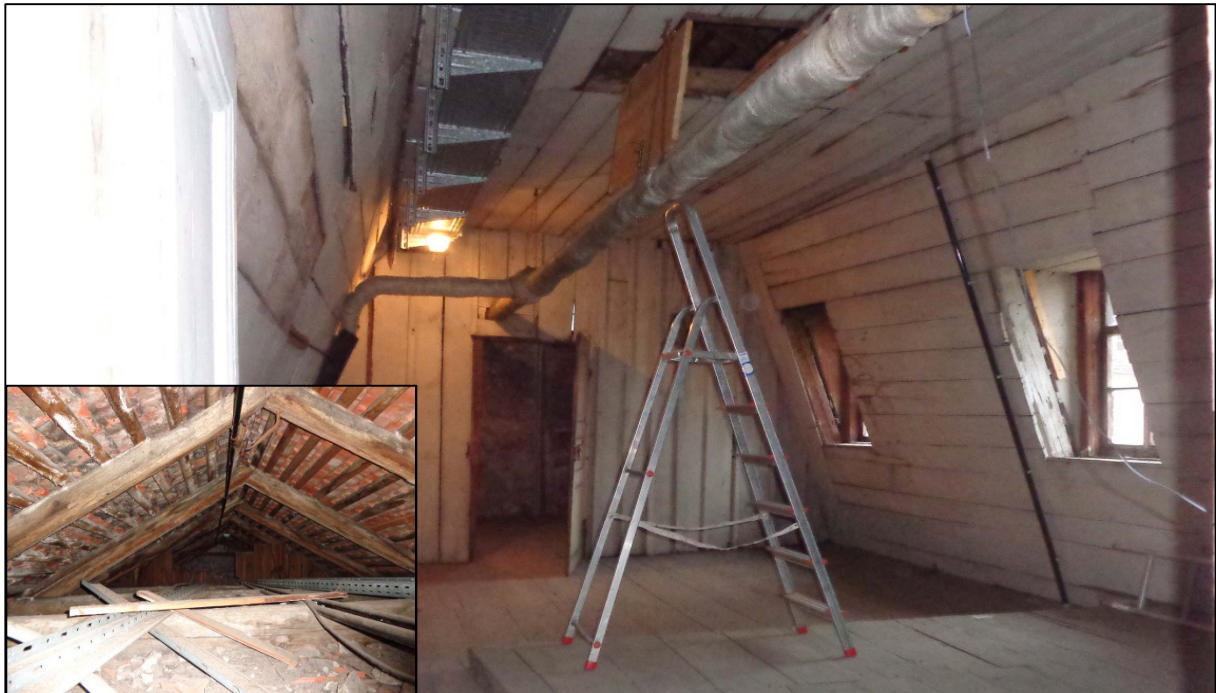
Abb. 03: Dachstuhl Goethe-Wohnhaus, Messpunkt 3
