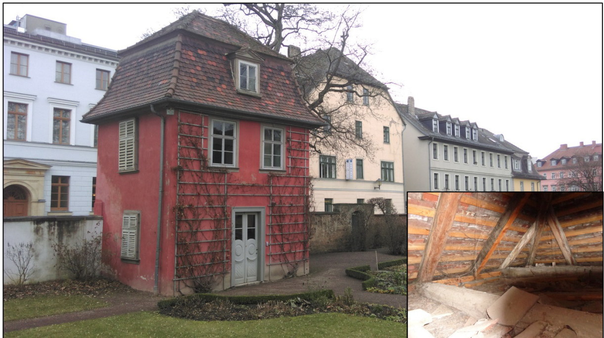
Abb. 05: Dachstuhl Goethe-Wohnhaus, Messpunkt 6 (Pavillon)
