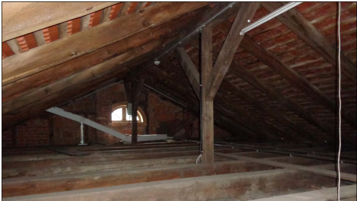
Abb. 02: Dachstuhl Goethe-Wohnhaus, Messpunkt 1
