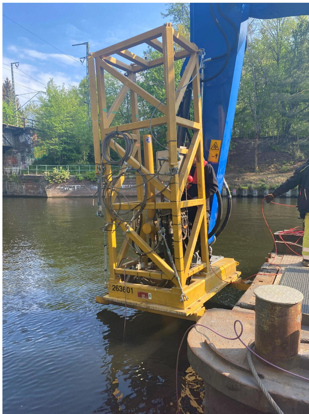
Abb. 2: CPT Anlage am Baggerarm während der Sondierung
