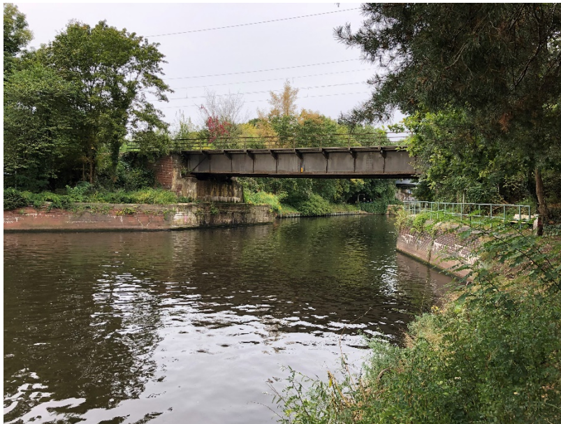
Abbildung 6: Ansicht Bahnbrücke von oberhalb
