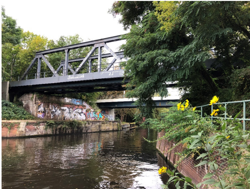
Abbildung 7: Ansicht S-Bahnbrücke von oberhalb
