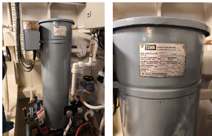
Aufnahmen des Kraftstoffvorwärmers zwecks Aus- /Einbau.
