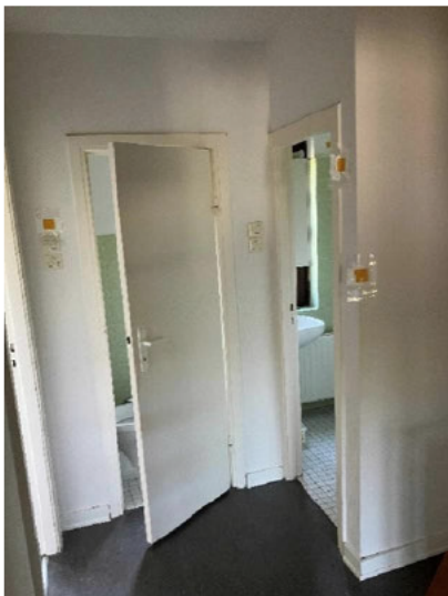
Proben-Nr. 49: EG und 1.OG, Tür und Türzarge, Anstrichstoff Blei 4000 mg/kg, Zink 12000 mg/kg
