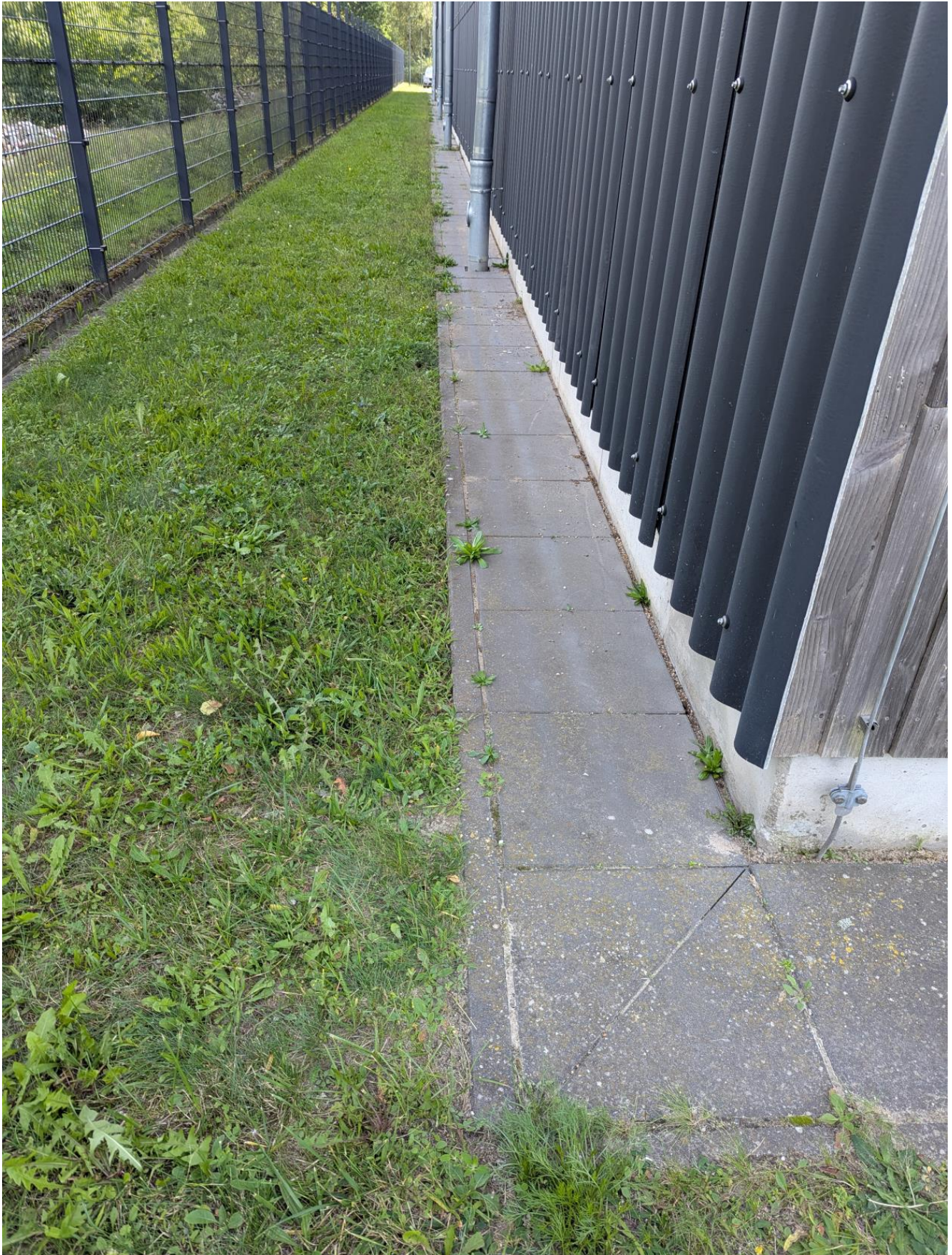
RH Traufstreifen (Betonwerkstein) Zaunseite
