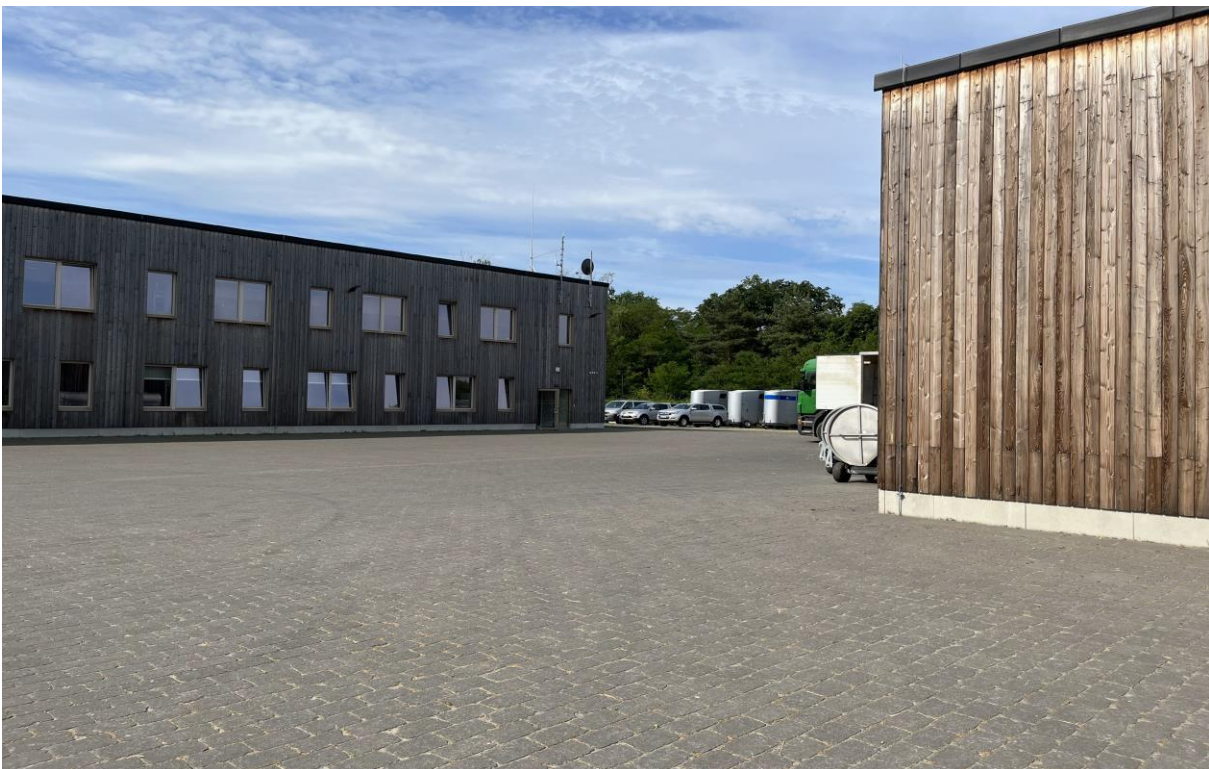
Hoffläche (Altbestand) zwischen Dienstgebäude und Stall mit Entwässerungsrinne / einfache Mulde
