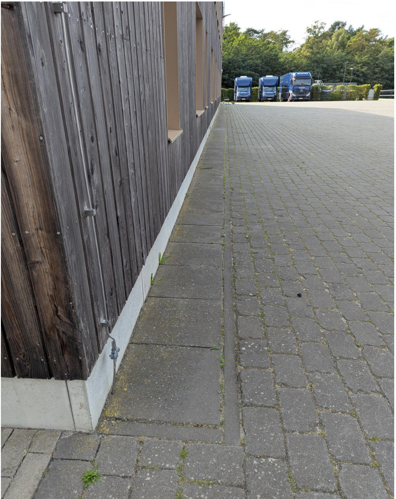
DG Hofseite mit Traufstreifen (Betonwerkstein)
