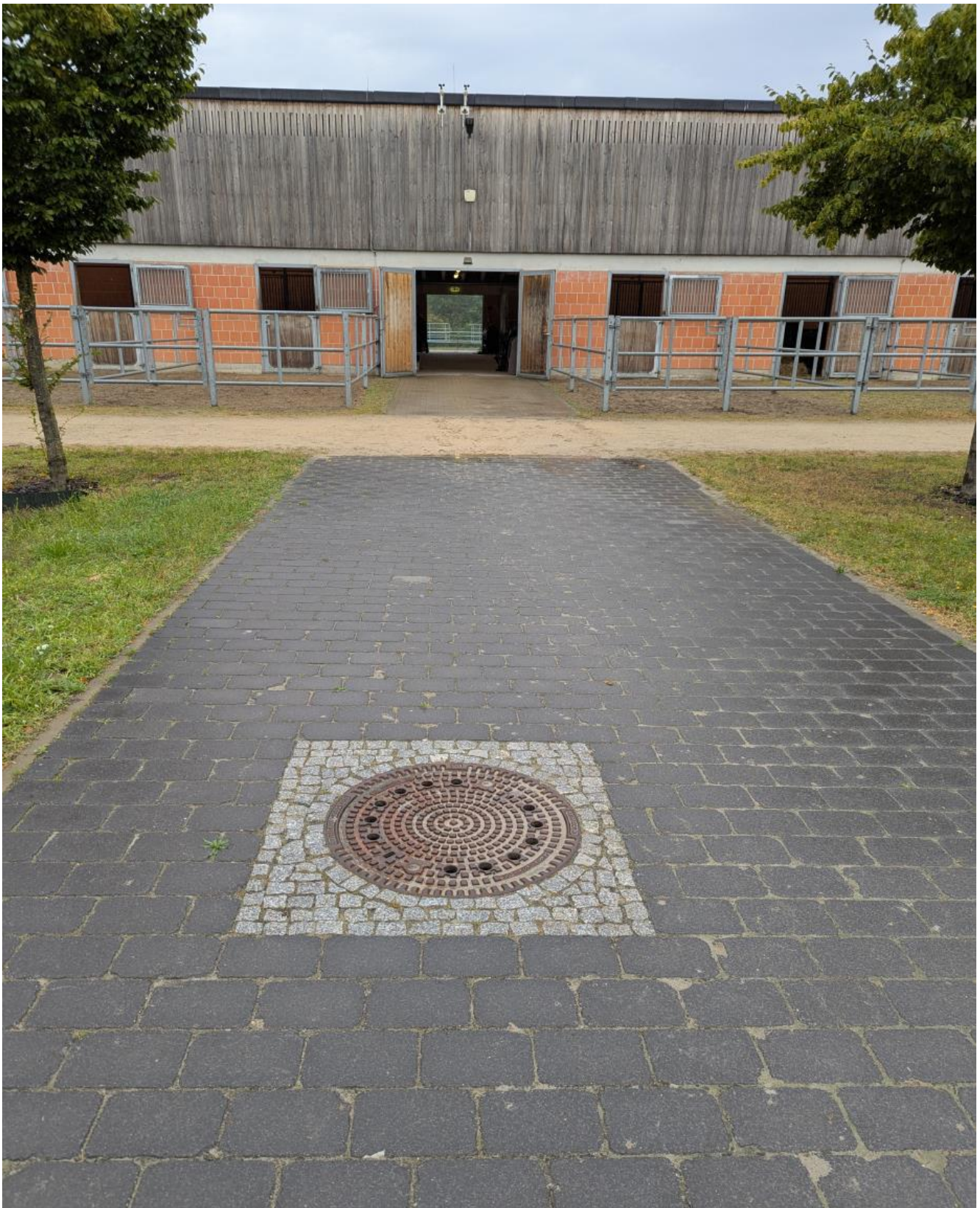
Gully am Stallgebäude rechts (Weg zwischen Versickerungsmulden)
