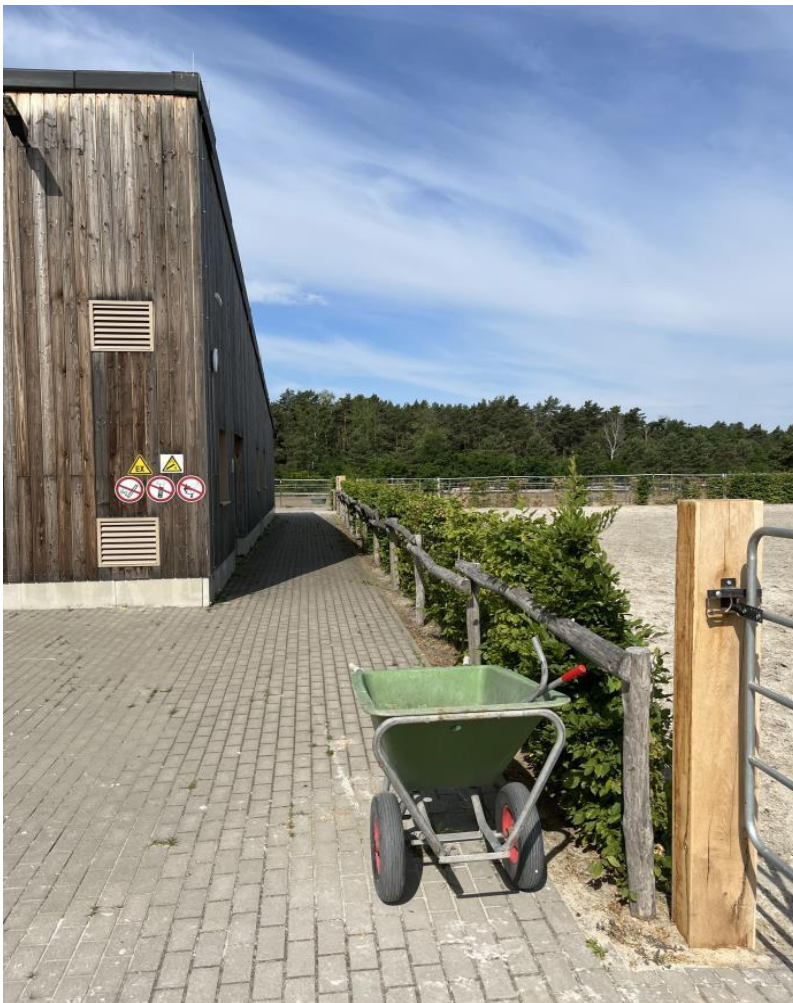
Pflasterung (Altbestand) Nordseite Stallgebäude
