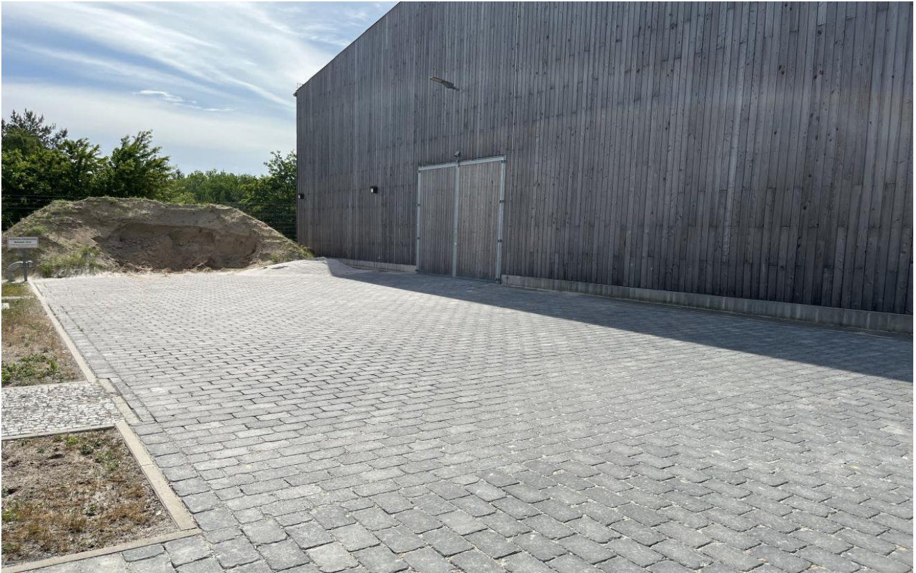
Neu gepflasterte Fläche an Nordseite Reithalle
