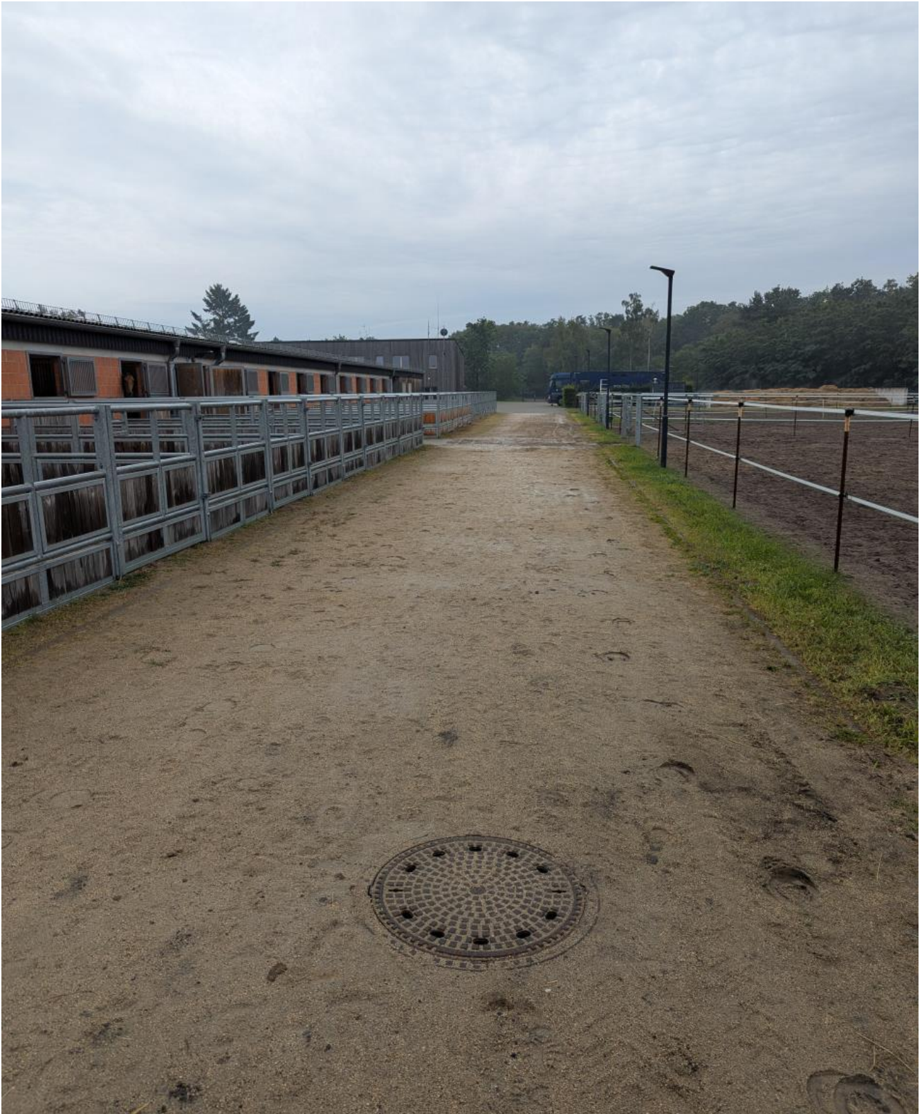
Gully am Stallgebäude links an den Koppeln (Sandweg)
