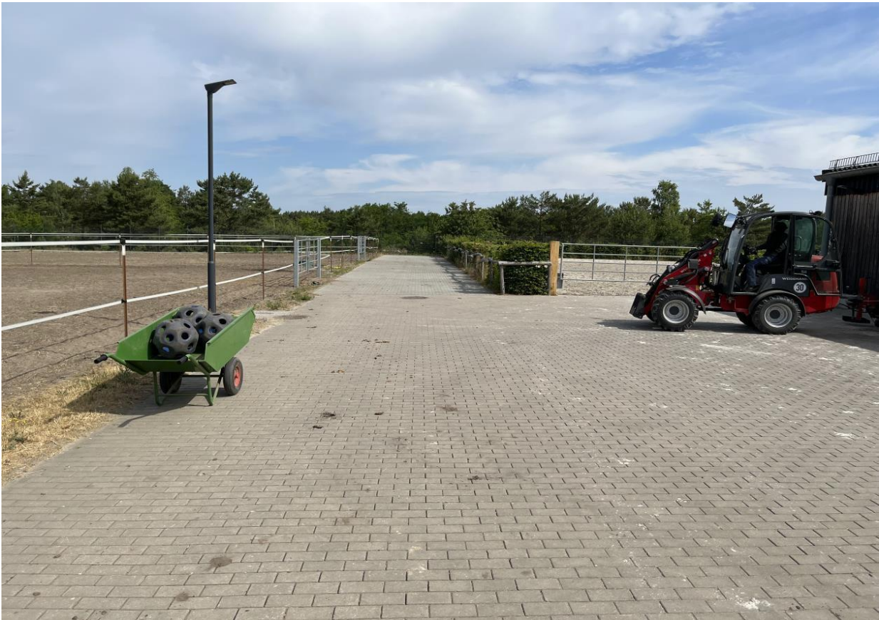
Pflasterung (Altbestand) am Stallgebäude Koppelseite und (Neubestand) zwischen Koppel u. Reitplatz
