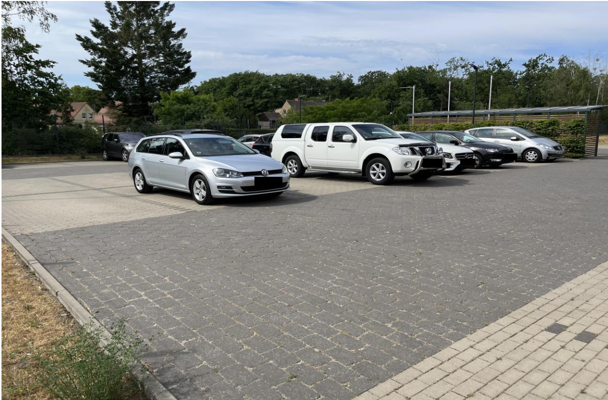
Parkplätze an Hauptzufahrt (Altbestand)
