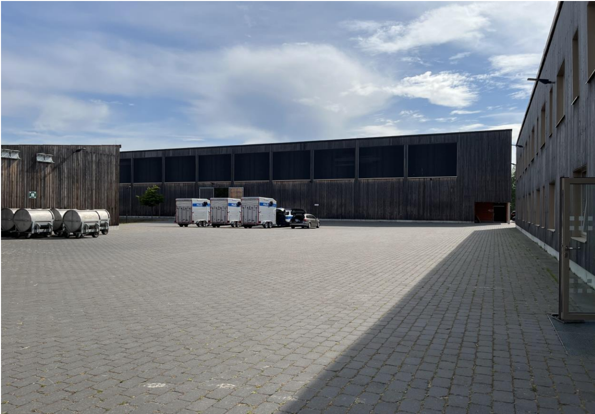
Altbestand Hoffläche vom Nebeneingang Dienstgebäude aus
