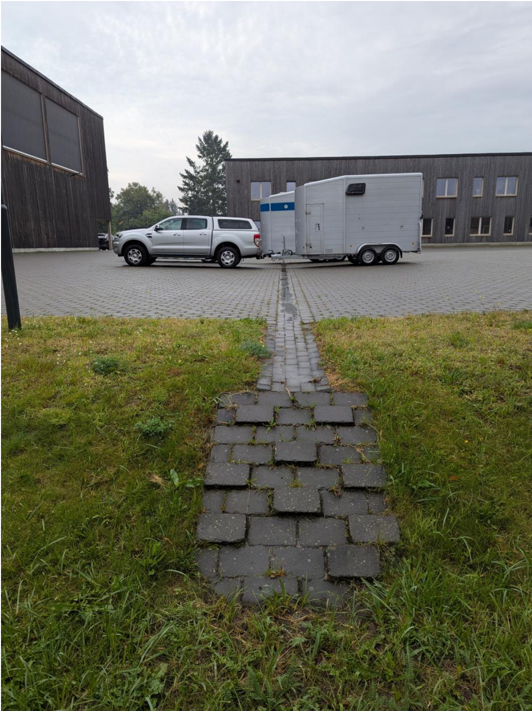
Entwässerungsrinne im Hof (einfache Mulde) - Einlauf Versickerungsmulde
