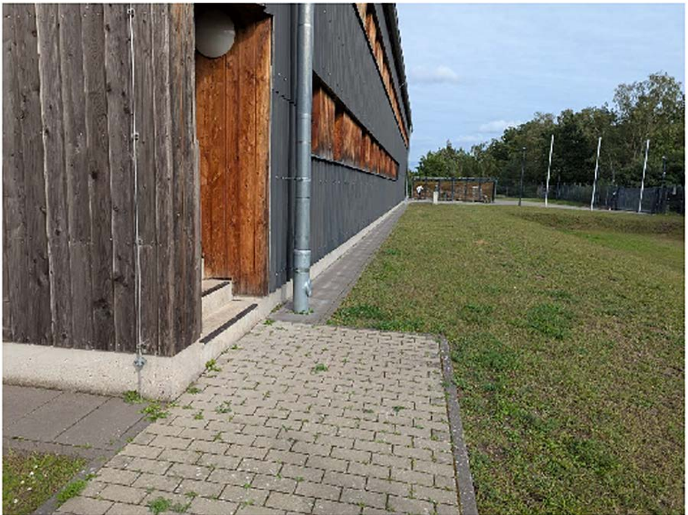
DG Straßenseite mit Traufstreifen (Betonwerkstein)
