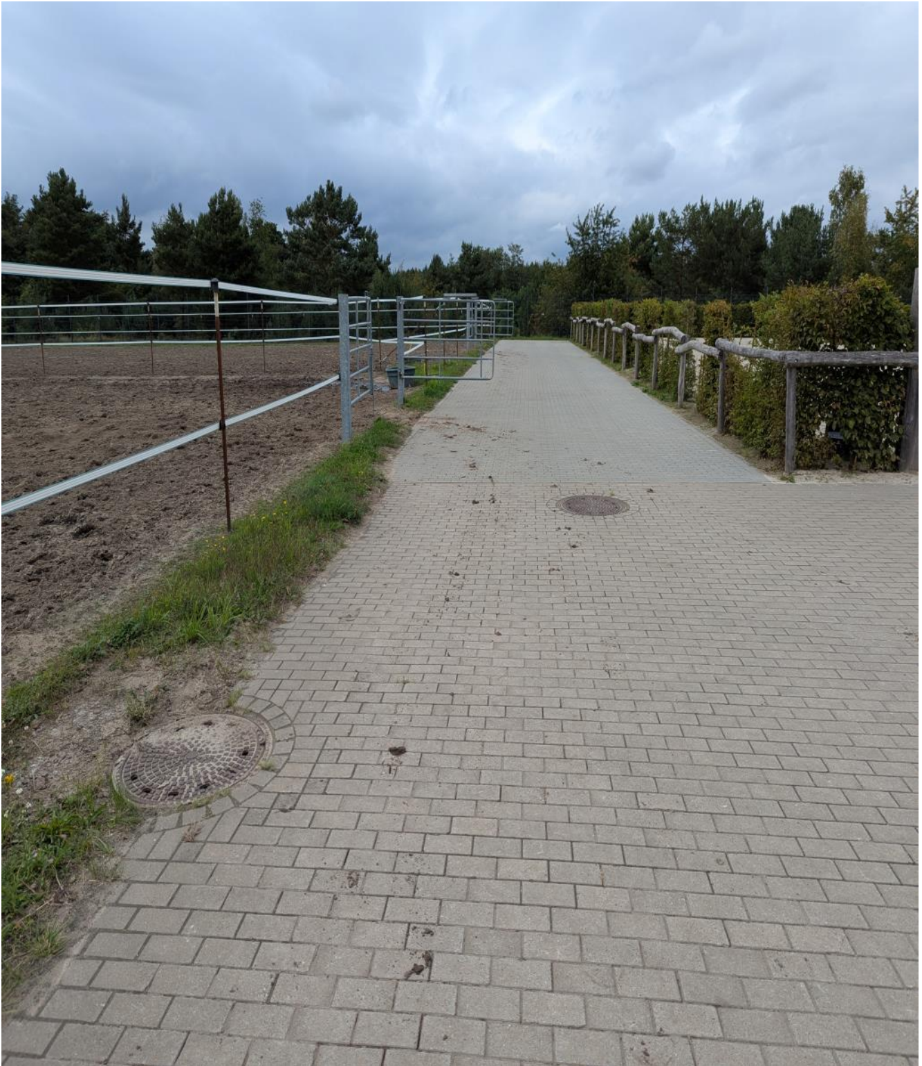
Gullys am Stallgebäude links zwischen Koppeln und Reitplatz
