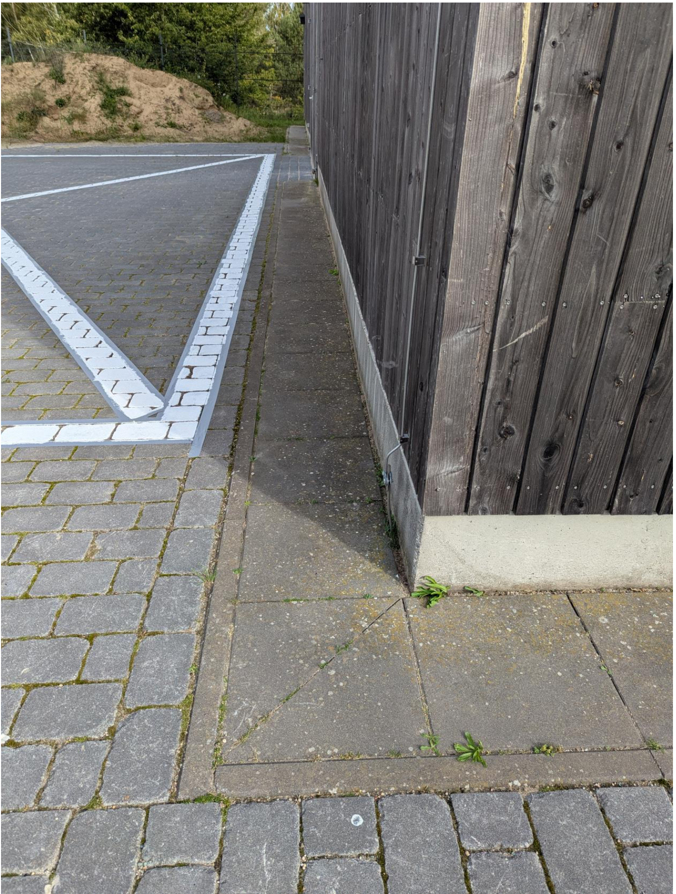
RH Traufstreifen (Betonwerkstein) Giebel Nordseite
