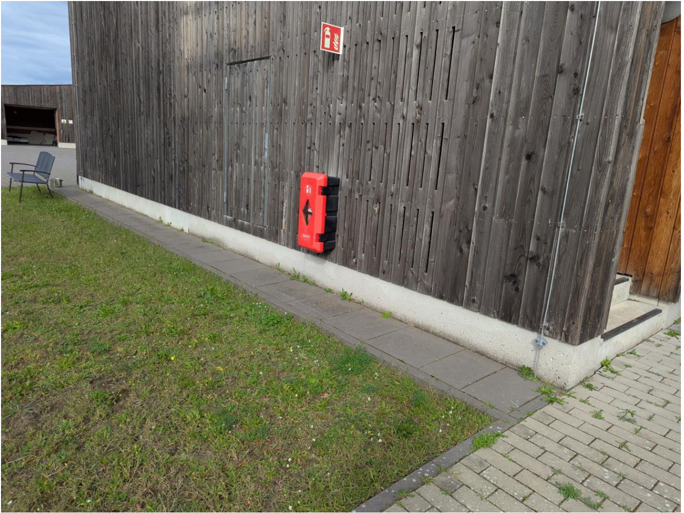
DG Giebel Westseite mit Traufstreifen (Betonwerkstein)
