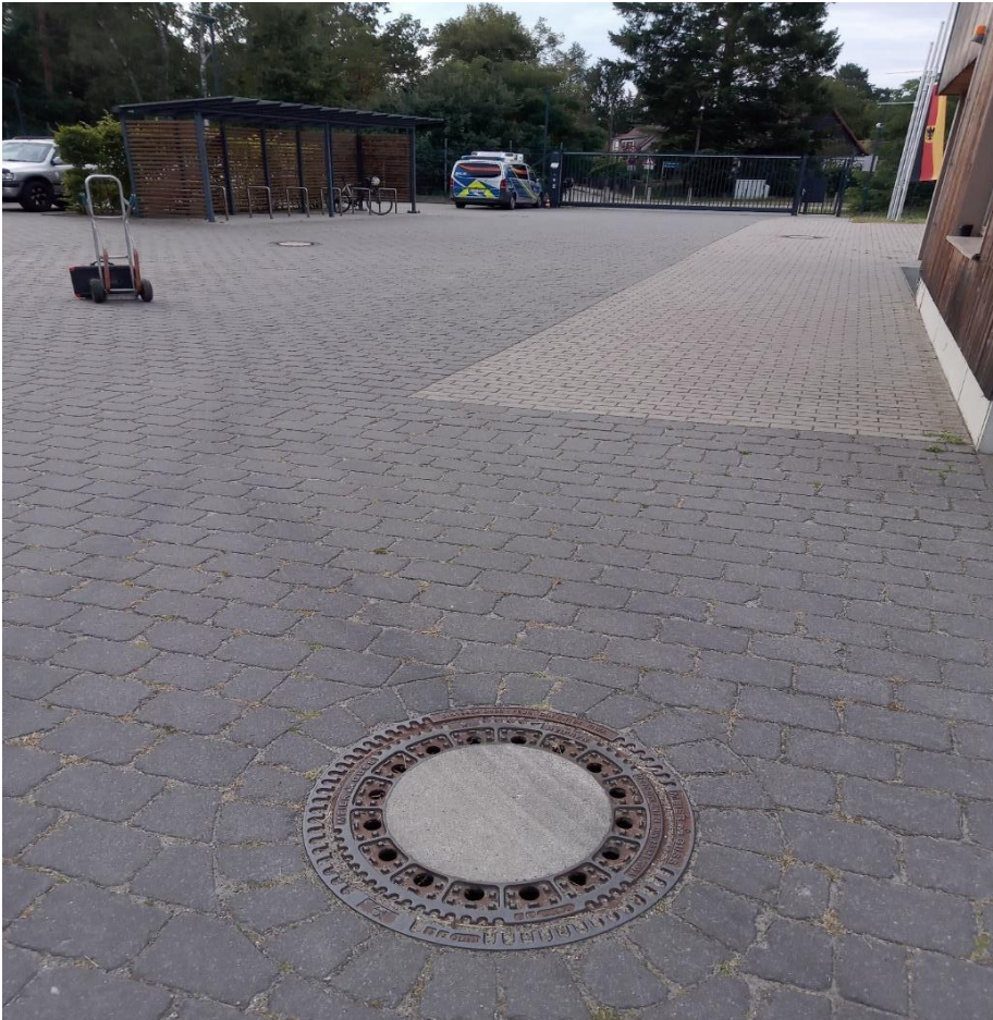
Pflasterung Hauptzufahrt (Altbestand)
