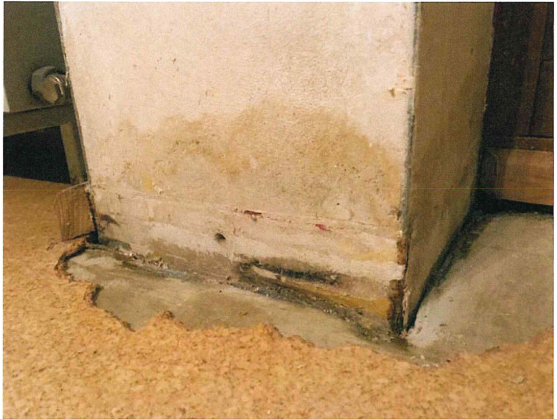
Bild 06: Wohnzimmer – Süd-/Westecke, innen
