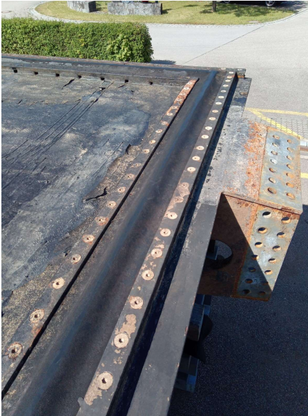
Sohlen- und Seitendichtung
