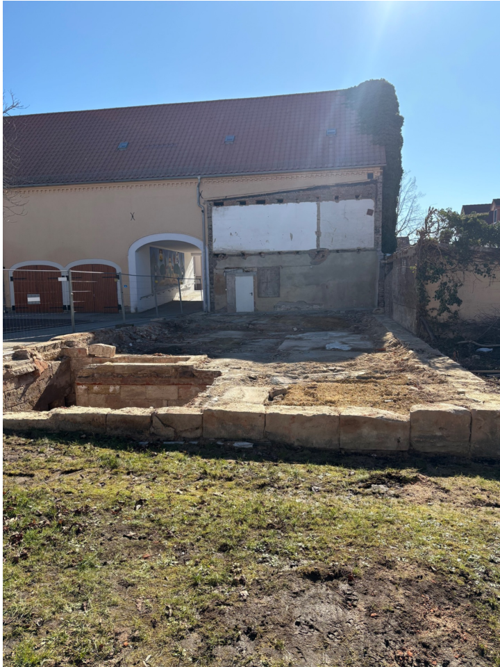
Foto: Baulücke nach Rückbau des Bestandsgebäudes
