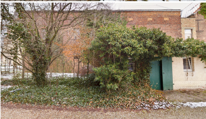
Fotos: Bestandsgebäude Altmarkt 11a vor Rückbau
