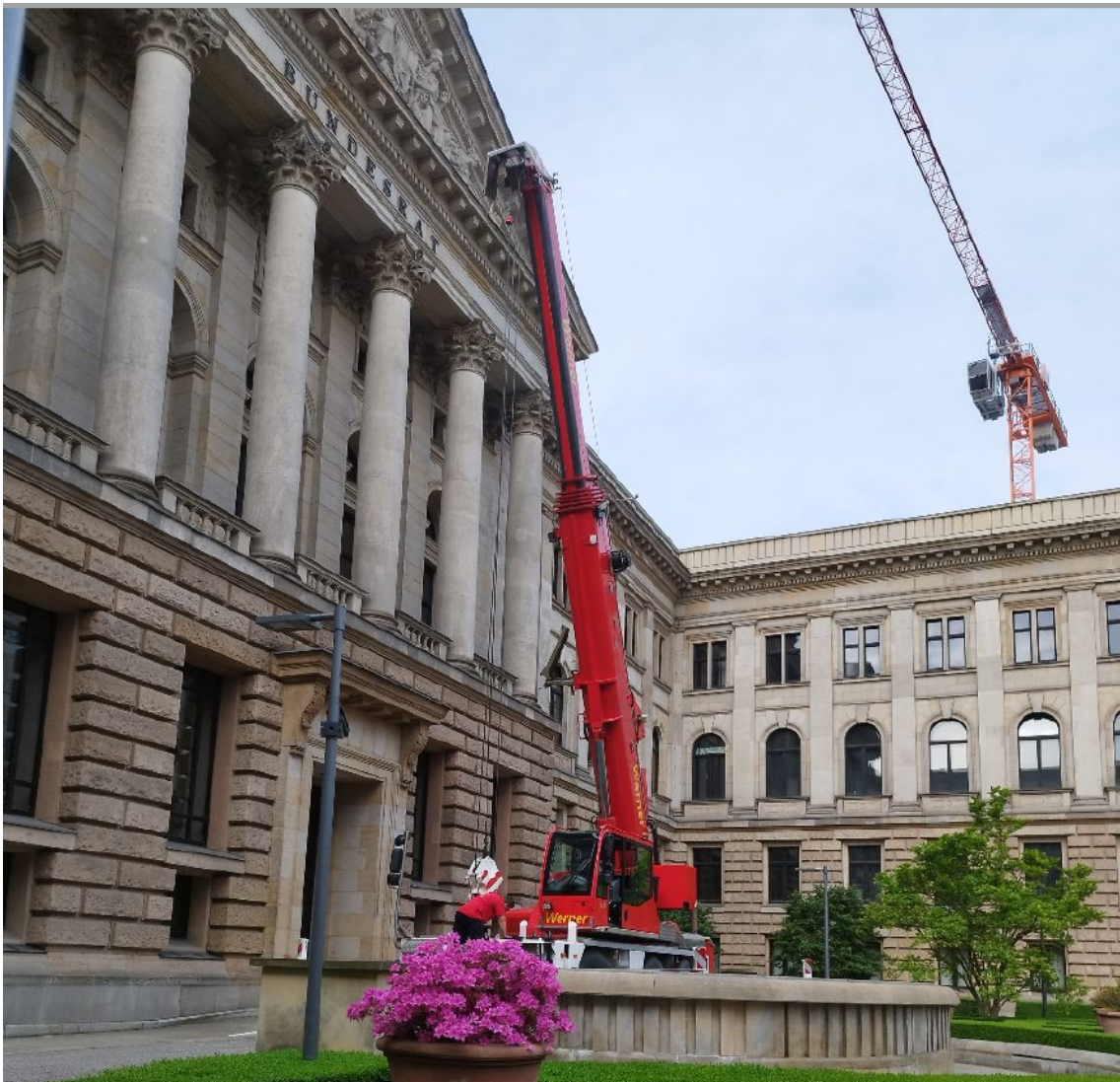
Austausch der Bepflanzung mittels entsprechenden Krans
