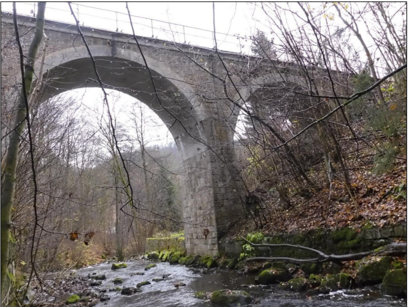
Teilansicht auf die zu untersuchende Segmentbogen-Brücke über die Behre bei Ilfeld
