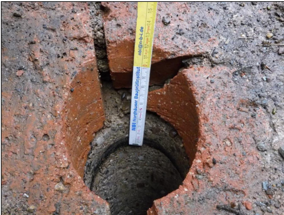
Bild 3: Lage der Dichtung, beispielhaft für KB 2 bis KB 4 und KB 7
