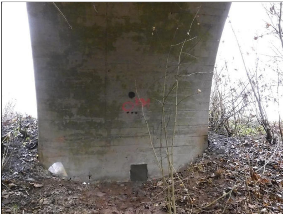
Bild 10: Widerlager 2, mit Instandsetzungsmörtel verschlossene Beprobungsstellen
