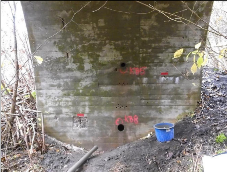
Bild 7: Widerlager 1, Ansicht auf die Beprobungsstellen
