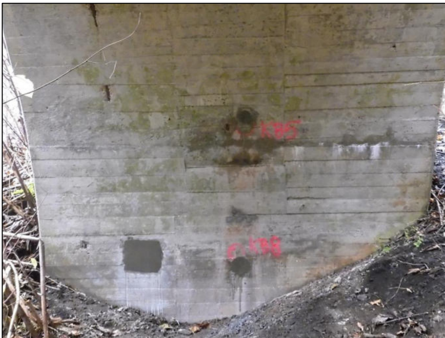
Bild 8: Widerlager 1, mit Instandsetzungsmörtel verschlossene Beprobungsstellen
