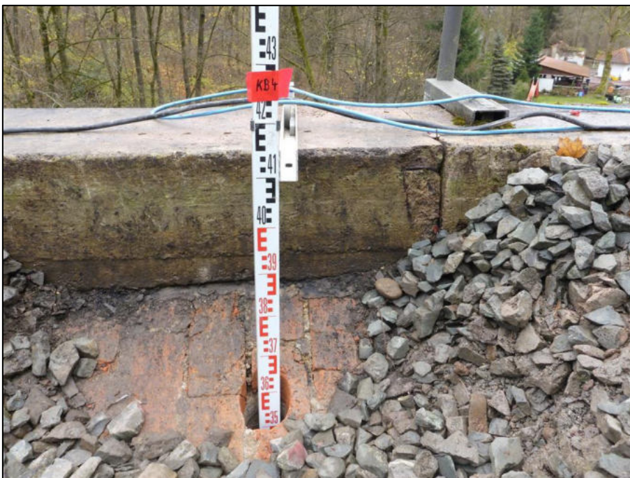
Bild 2: Hier beispielhafte Vorort-Situation für (KB 2 bis KB 4 und KB 7). Gut sichtbar der mit Ziegeln ausgekleidete Trog.
