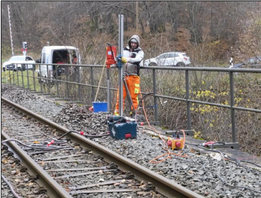
Bild 1: Kernbohrarbeiten am Überbau
