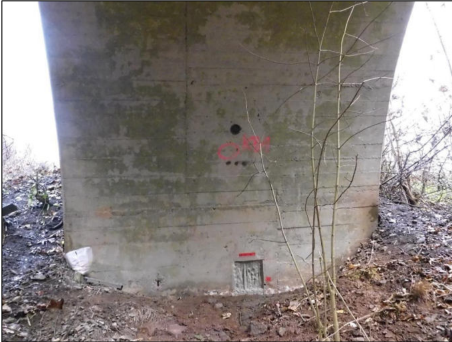
Bild 9: Widerlager 2, Ansicht auf die Beprobungsstellen
