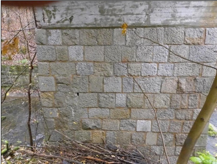
Bild 11: Pfeiler 1, Lage der Probenahmestelle für die Bindemittelanalyse
