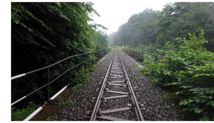
Blick über das Bauwerk in Richtung Wernigerode
