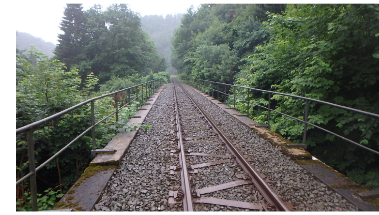
Blick über das Bauwerk in Richtung Nordhausen
