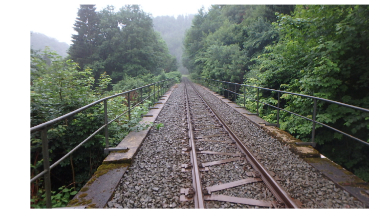
Blick über das Bauwerk in Richtung Nordhausen
