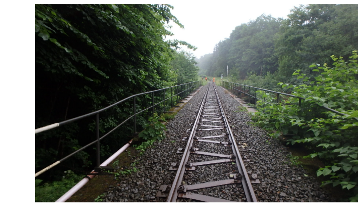
Blick über das Bauwerk in Richtung Wernigerode
